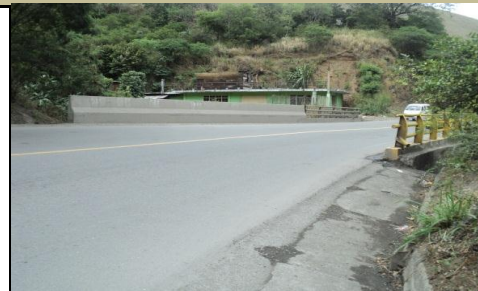
NO EXISTE PLACA DE IDENTIFICACIÓN
