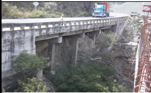
FOTO 3: VISTA PANORÁMICA LONGITUDINAL
