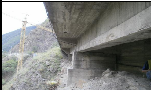
FOTO 3: VISTA PANORÁMICA LONGITUDINAL
