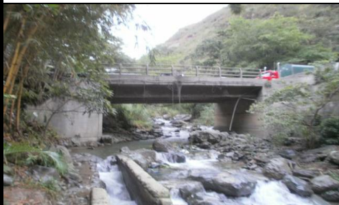
FOTO 3: VISTA PANORAMICA LONGITUDINAL
