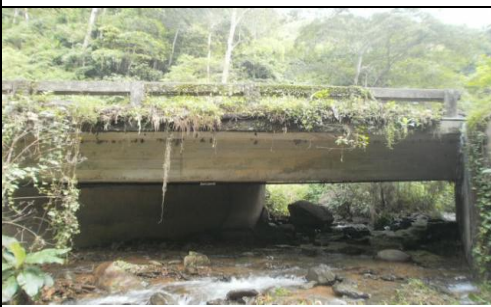
FOTO 3: VISTA PANORÁMICA LONGITUDINAL
