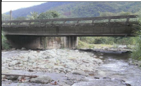
FOTO 3: VISTA PANORÁMICA LONGITUDINAL
