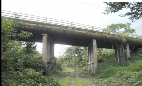
FOTO 3: VISTA PANORÁMICA LONGITUDINAL
