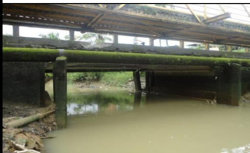
FOTO 3: VISTA PANORÁMICA LONGITUDINAL
