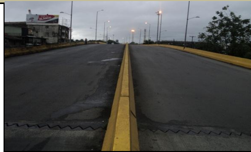
NO EXISTE PLACA DE IDENTIFICACIÓN
