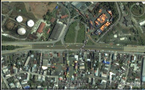
FOTO 1: UBICACIÓN PUENTE GOOGLE EARTH
