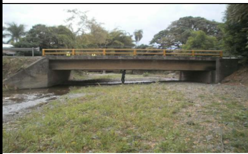
FOTO 3: VISTA PANORÁMICA LONGITUDINAL
