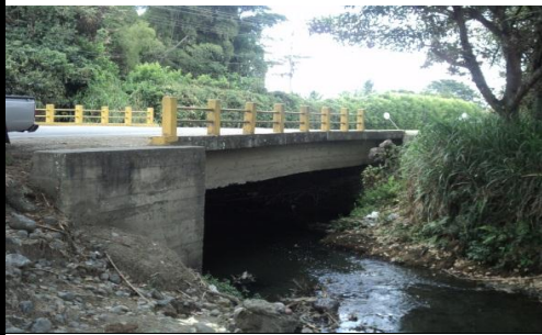
FOTO 3: VISTA PANORAMICA LONGITUDINAL
