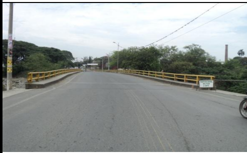
FOTO 3: VISTA PANORAMICA LONGITUDINAL
