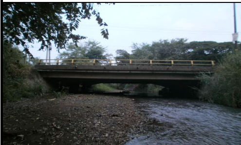
FOTO 3: VISTA PANORAMICA LONGITUDINAL
