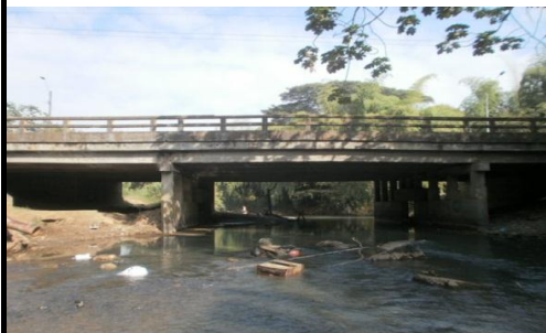
FOTO 3: VISTA PANORAMICA LONGITUDINAL
