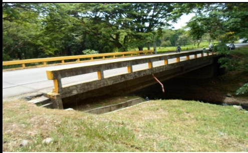
FOTO 3: VISTA PANORÁMICA LONGITUDINAL
