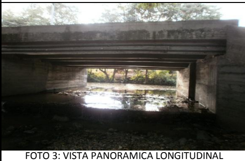
FOTO 3: VISTA PANORÁMICA LONGITUDINAL
