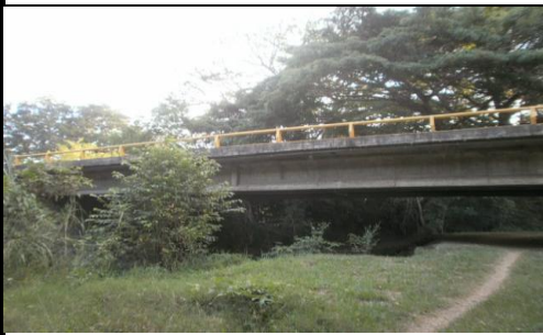
FOTO 3: VISTA PANORAMICA LONGITUDINAL
