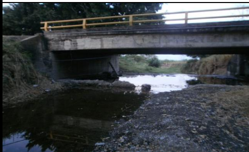
FOTO 3: VISTA PANORÁMICA LONGITUDINAL
