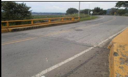
FOTO 3: VISTA PANORAMICA LONGITUDINAL
