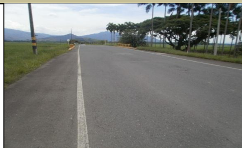
NO EXISTE PLACA DE IDENTIFICACIÓN
