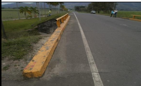
FOTO 3: VISTA PANORAMICA LONGITUDINAL
