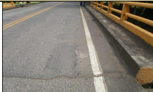
NO EXISTE PLACA DE IDENTIFICACIÓN
