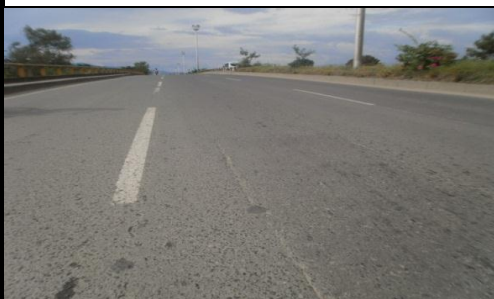
FOTO 3: VISTA PANORAMICA LONGITUDINAL
