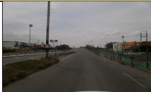
NO EXISTE PLACA DE IDENTIFICACIÓN
