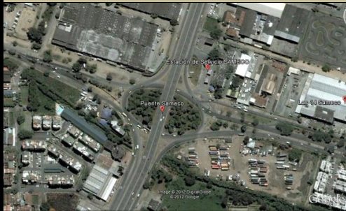
FOTO 1: UBICACIÓN PUENTE GOOGLE EARTH
