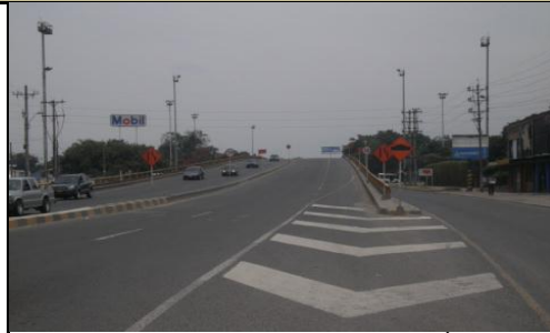
NO EXISTE PLACA DE IDENTIFICACIÓN
