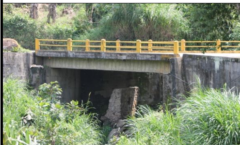
FOTO 3: VISTA PANORAMICA LONGITUDINAL
