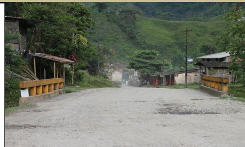
FOTO 2: PLACA DE IDENTIFICACION-NO EXSITE
