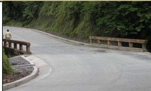
FOTO 2: PLACA DE IDENTIFICACIÓN-NO EXISTE
