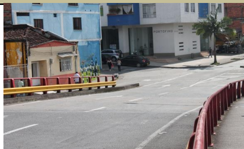
FOTO 2: PLACA DE IDENTIFICACION-NO EXSITE
