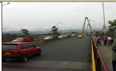
FOTO 2: PLACA DE IDENTIFICACION-NO EXSITE
