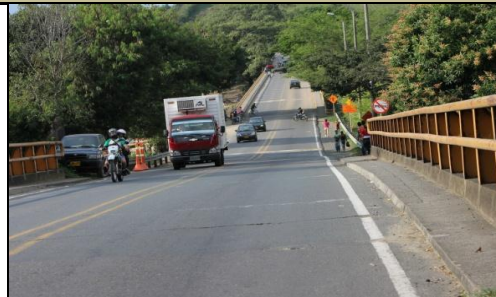
FOTO 2: PLACA IDENTIFICACIÓN PUENTE-NO EXISTE
