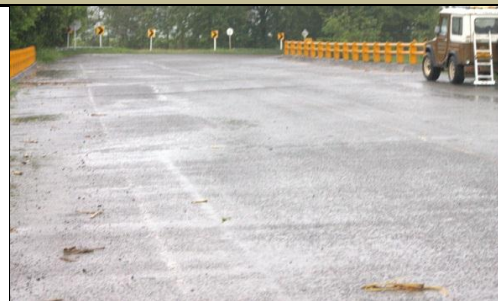
FOTO 2: PLACA DE IDENTIFICACION-NO EXSITE
