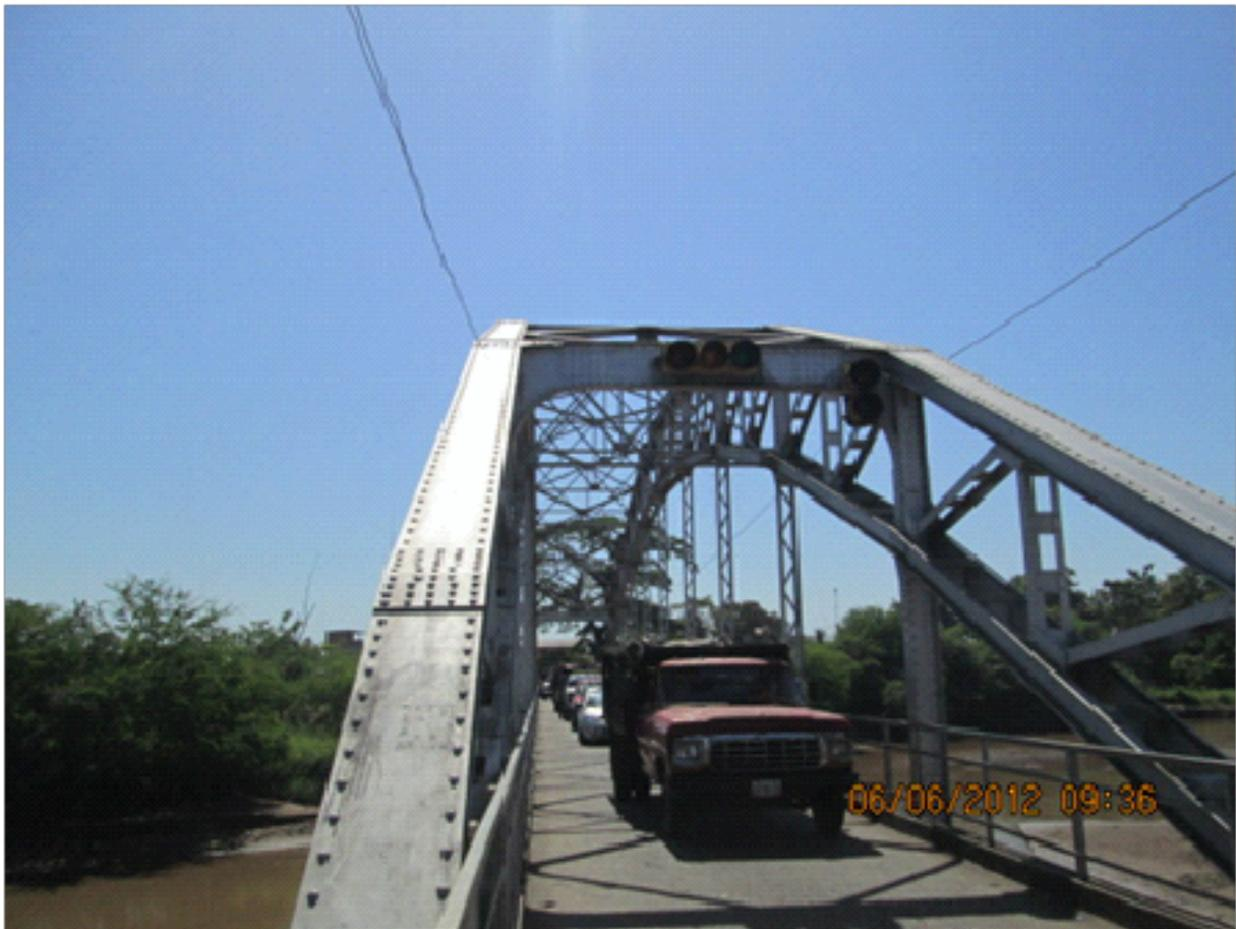
Componente.....: 14 Elementos de armadura
