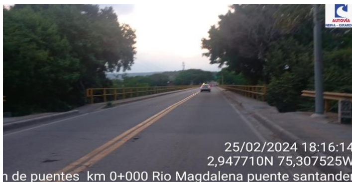
FOTO N° 1 PANORAMICA ACCESO NORTE PUENTE SANTANDER K0+000 UF1,5
