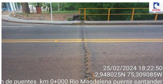
FOTO N° 2 JUNTA DE DILATACION COSTADO NORTE PUENTE SANTANDER K0+000 UF1,5
