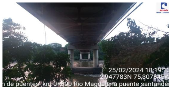
FOTO N° 5 VIGAS Y PILAS PUENTE SANTANDER K0+000 UF1,5
