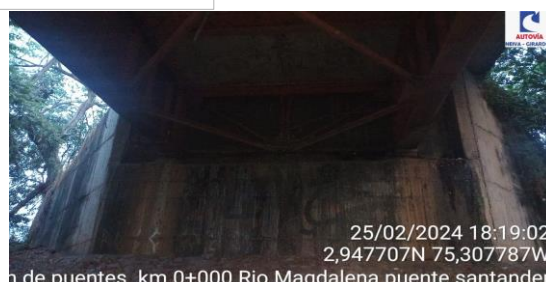
FOTO N° 3 ESTRIBO COSTADO SUR PUENTE SANTANDER K0+000 UF1,5
