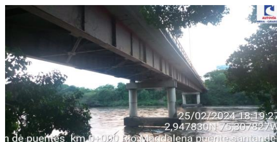
FOTO N° 7 VIGAS DE LA ESTRUCTURA PUENTE SANTANDER K0+000 UF1,5
