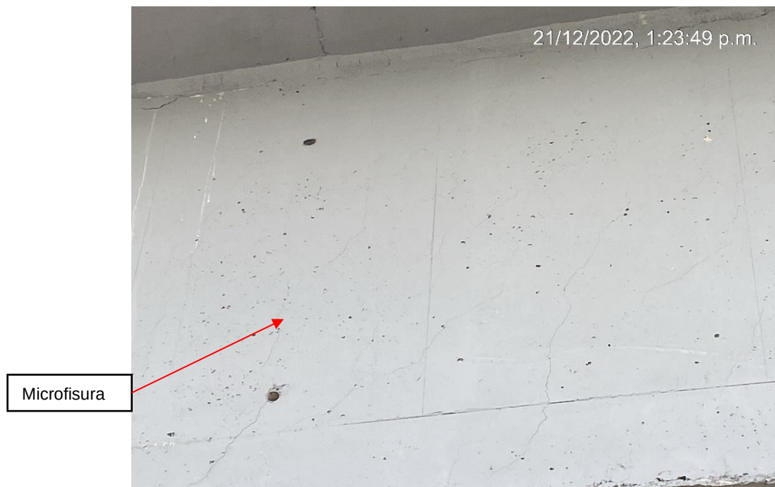
Fotografía 31. Vista De Viga Cajón Apoyo Columna Fuente: Sinerging S.A.S.
