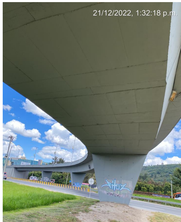
Fotografía 2. Vista General Puente Teletón Curvo vista estribo Eje 7 Fuente: Sinerging S.A.S.
