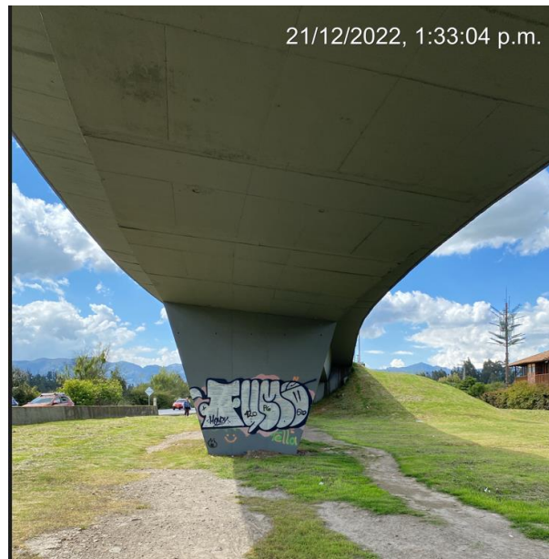
Fotografía 1. Vista General Puente Teletón Curvo vista estribo Eje 1 Fuente: Sinerging S.A.S.
