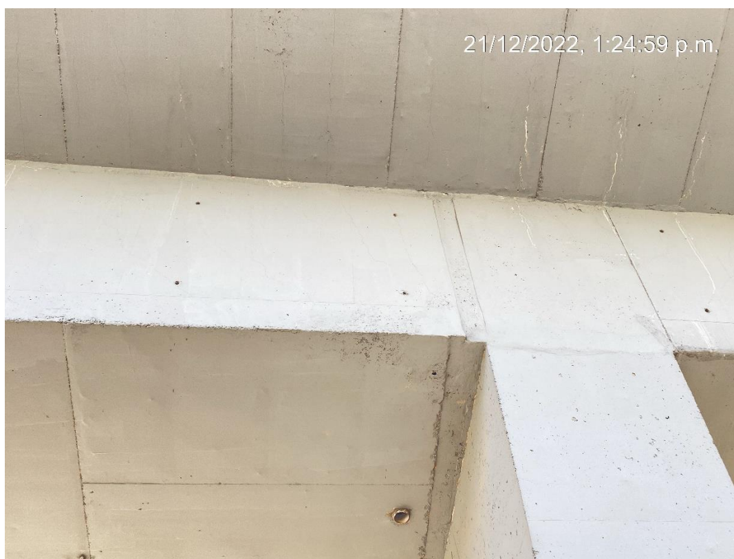
Fotografía 26. Vista de losa maciza Fuente: Sinerging S.A.S.
