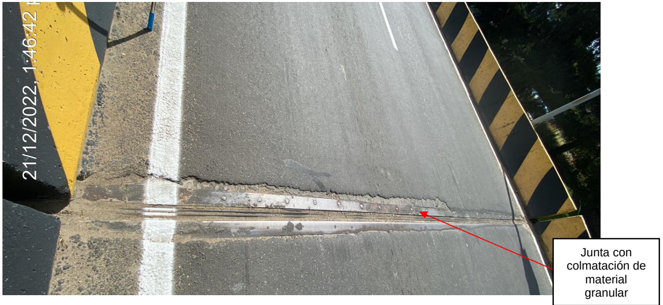
Fotografía 6. Vista Junta Estribo Eje 7 Fuente: Sinerging S.A.S.
