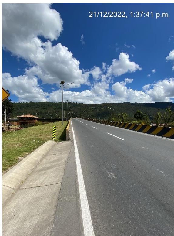
Fotografía 3. Vista General Puente Teletón Curvo Acceso Estribo eje 1 Fuente: Sinerging S.A.S.
