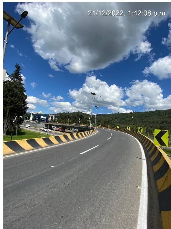
Fotografía 4. Vista Puente Teletón Curvo superficie de asfalto Fuente: Sinerging S.A.S.
