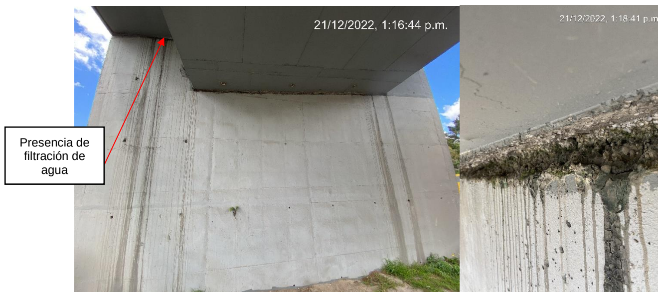
Fotografía 24. Vista Estribo Eje 7 Fuente: Sinerging S.A.S.
