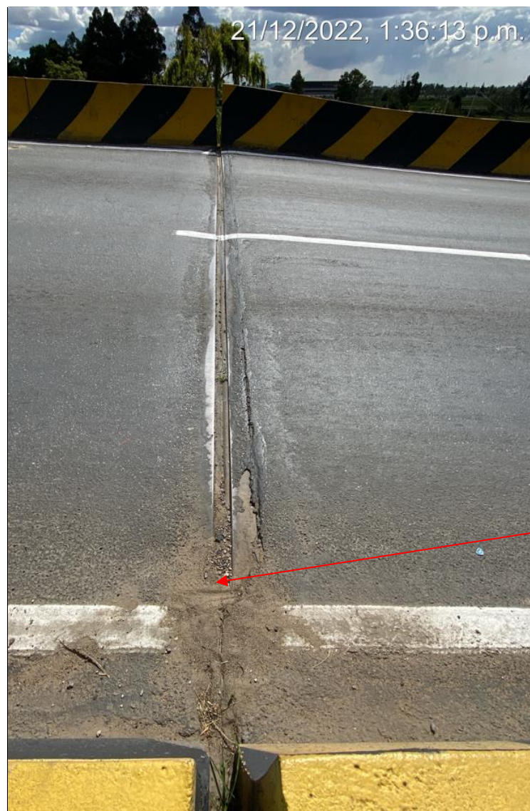
Fotografía 5. Vista Junta Estribo Eje 1 Fuente: Sinerging S.A.S.
