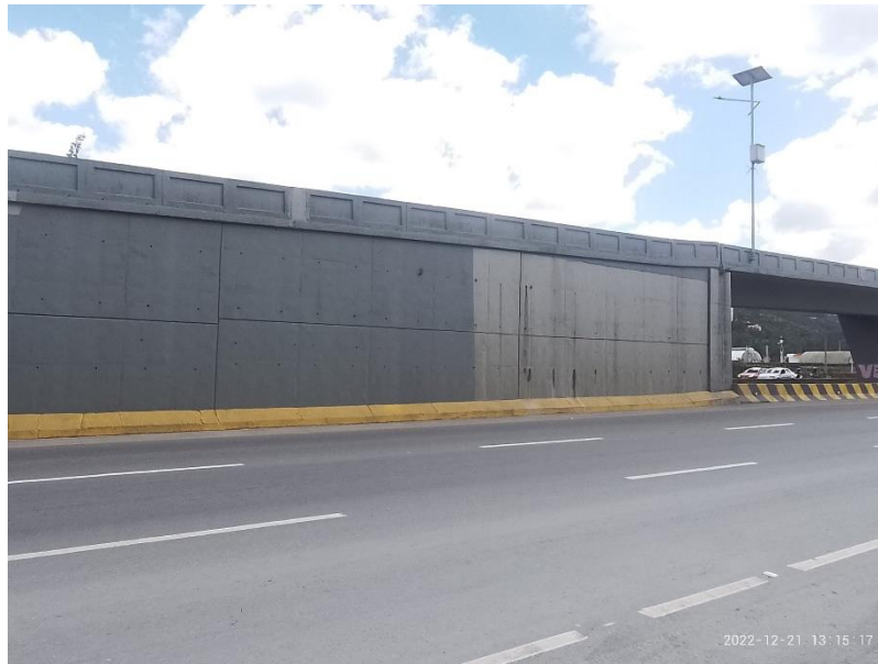
Fotografía 21. Vista Aleta Estribo Eje 7 Costado Izquierdo Fuente: Sinerging S.A.S.
