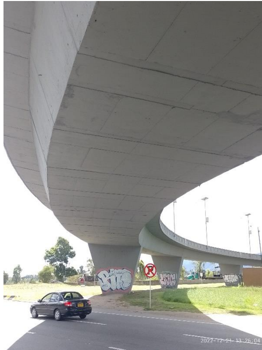
Fotografía 28. Vista General de viga cajón Fuente: Sinerging S.A.S.
