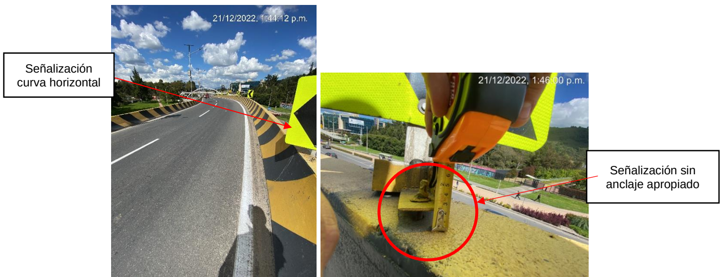
Fotografía 13. Señalización de Curva Horizontal
