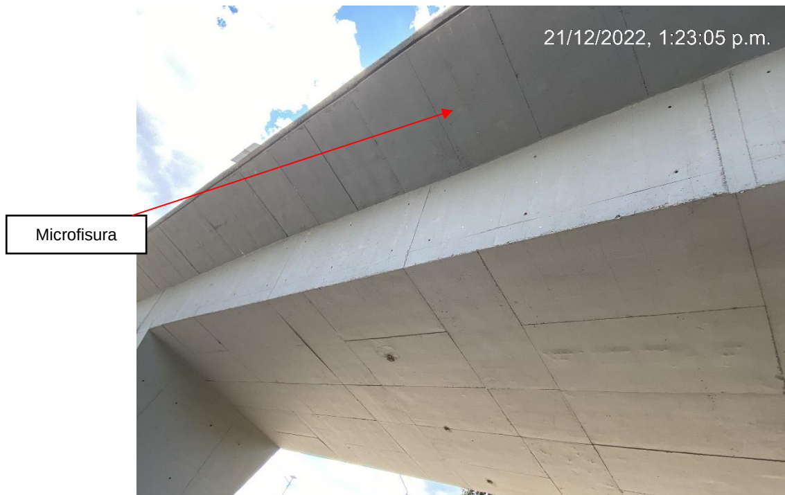
Fotografía 27. Vista De Losa Maciza Voladizos Fuente: Sinerging S.A.S.
