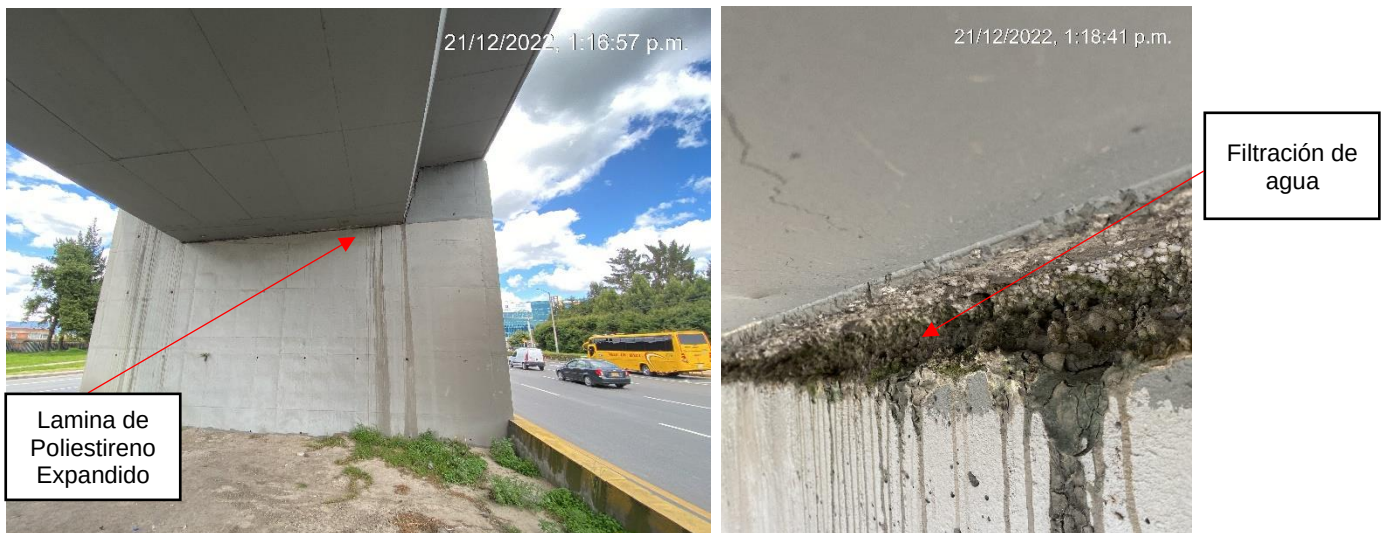
Fotografía 17. Vista general de apoyos en estribo Fuente: Sinerging S.A.S.
