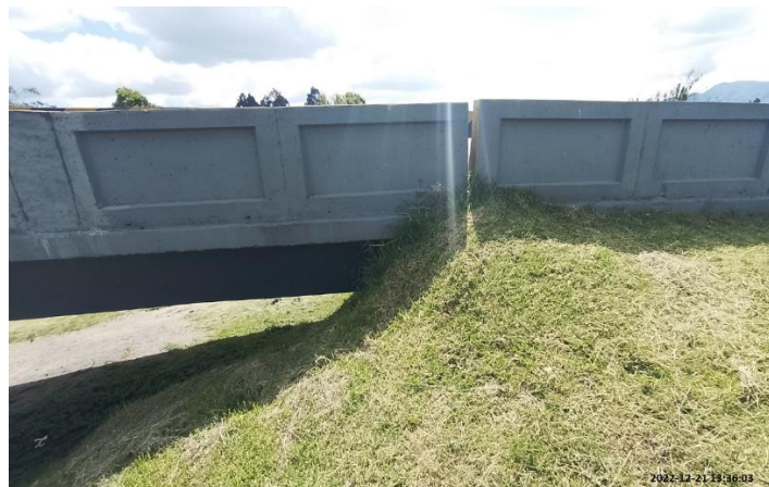
Fotografía 20. Vista Aleta Estribo Eje 1 Costado Derecho Fuente: Sinerging S.A.S.
