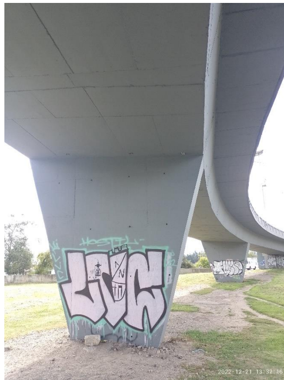
Fotografía 25. Vista columna típica Fuente: Sinerging S.A.S.
