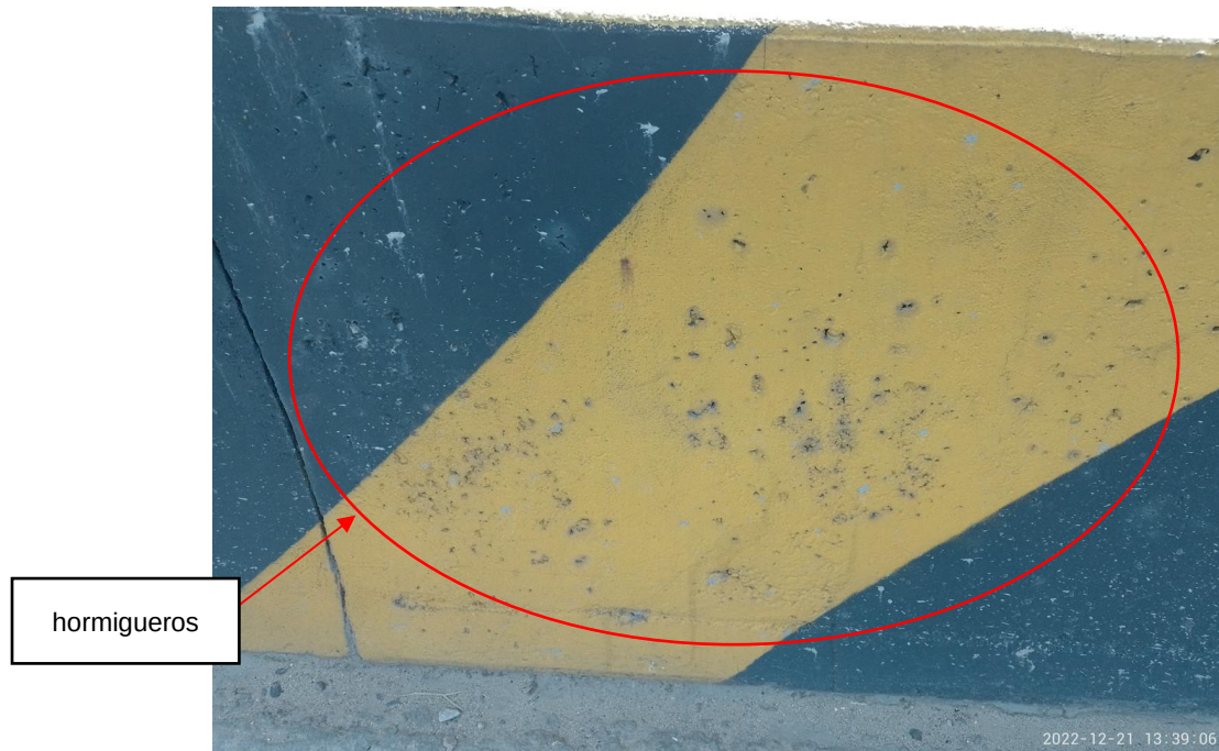
Fotografía 10. Baranda en concreto Fuente: Sinerging S.A.S.
