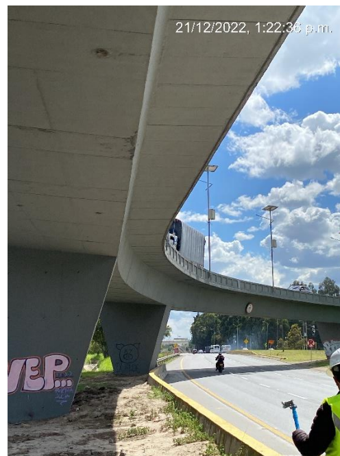
Fotografía 18. Vista general de apoyos en pilas Fuente: Sinerging S.A.S.
