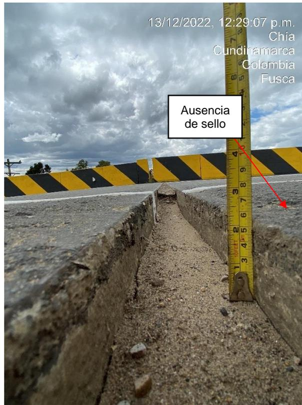
Fotografía 5. Vista Junta Estribo Eje 1 Ausencia De Sello Elastomérico.
