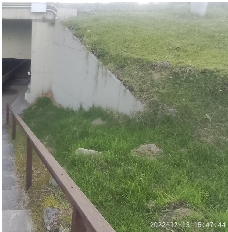
Fotografía 14. Vista Aleta Estribo 1 Costado Izquierdo Fuente: Sinerging S.A.S.
