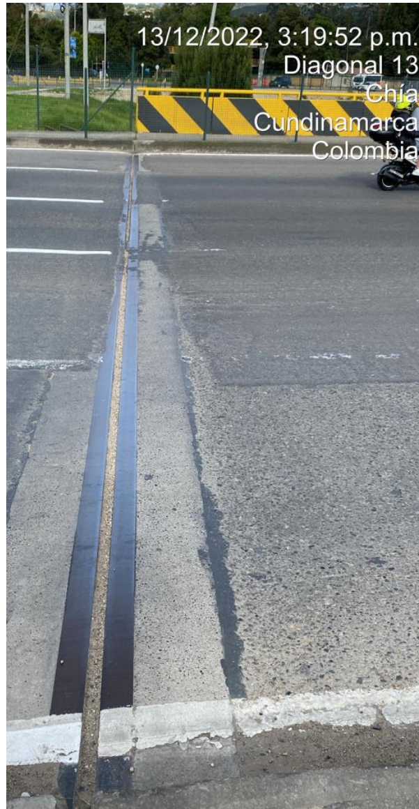
Fotografía 3. Vista Junta Estribo 1 Rio Bogotá Nuevo Fuente: Sinerging S.A.S.
