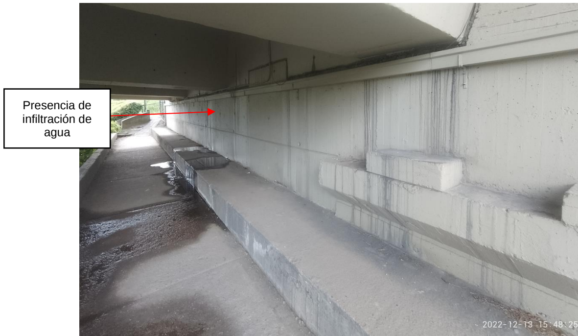
Fotografía 17. Vista Estribo 1 Rio Bogotá Nuevo Fuente: Sinerging S.A.S.
