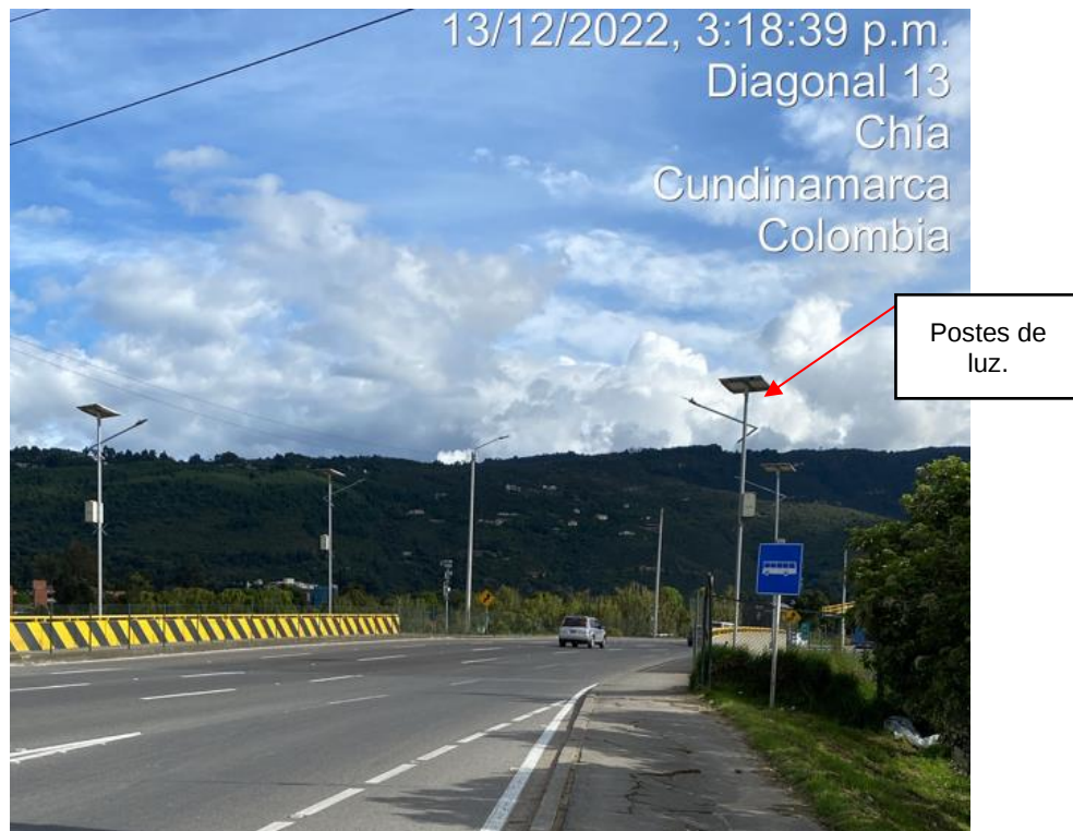
Fotografía 9. Iluminación Del Puente Fuente: Sinerging S.A.S.
