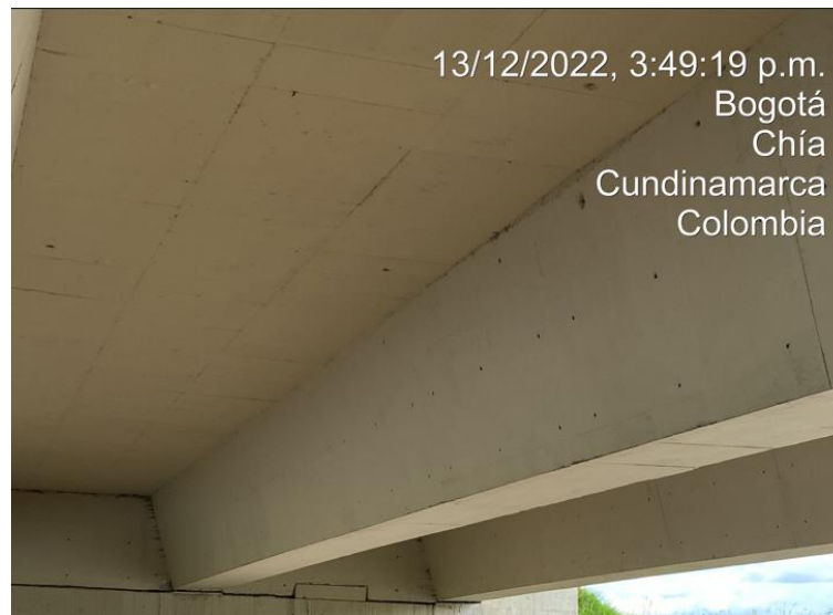
Fotografía 19. Vista De Prelosa + Losa Fundida In Situ Fuente: Sinerging S.A.S.
