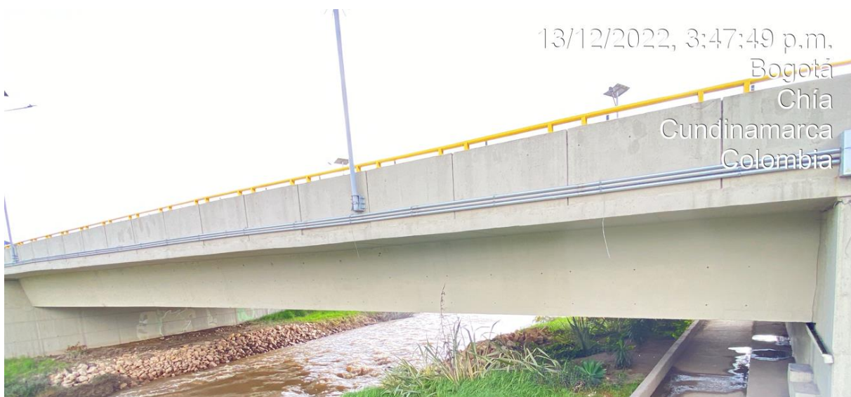
Fotografía 20. Vista de Vigas Puente Rio Bogotá Nuevo Fuente: Sinerging S.A.S.
