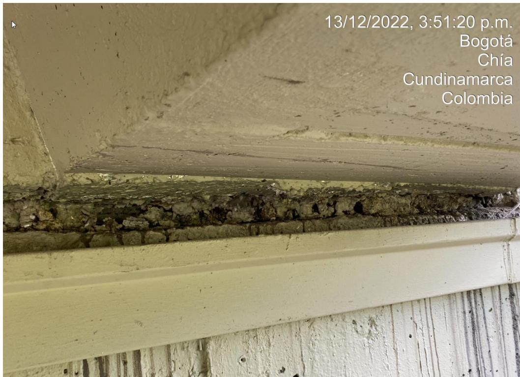
Fotografía 12. Vista Apoyo Neopreno Puente Rio Bogotá Nuevo Fuente: Sinerging S.A.S.
