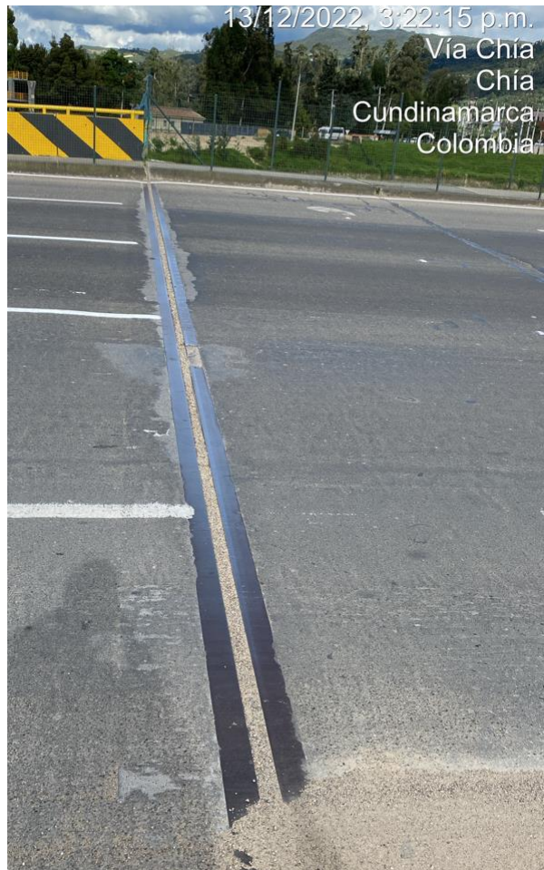
Fotografía 4. Vista Junta Estribo 2 Río Bogotá Nuevo Fuente: Sinerging S.A.S.
