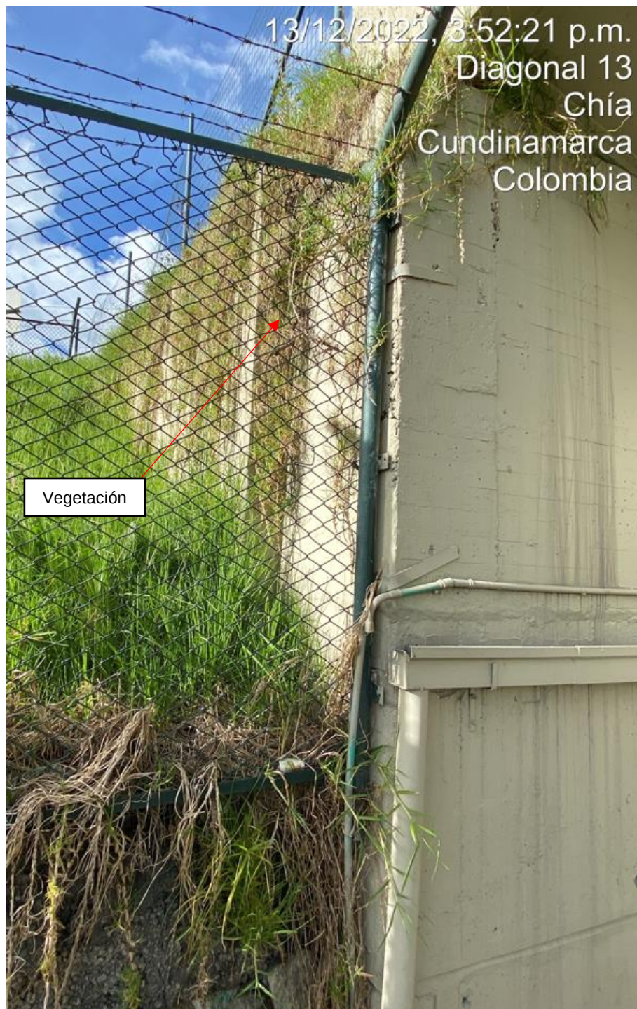
Fotografía 13. Vista Aleta Estribo 1 Costado Derecho Fuente: Sinerging S.A.S.
