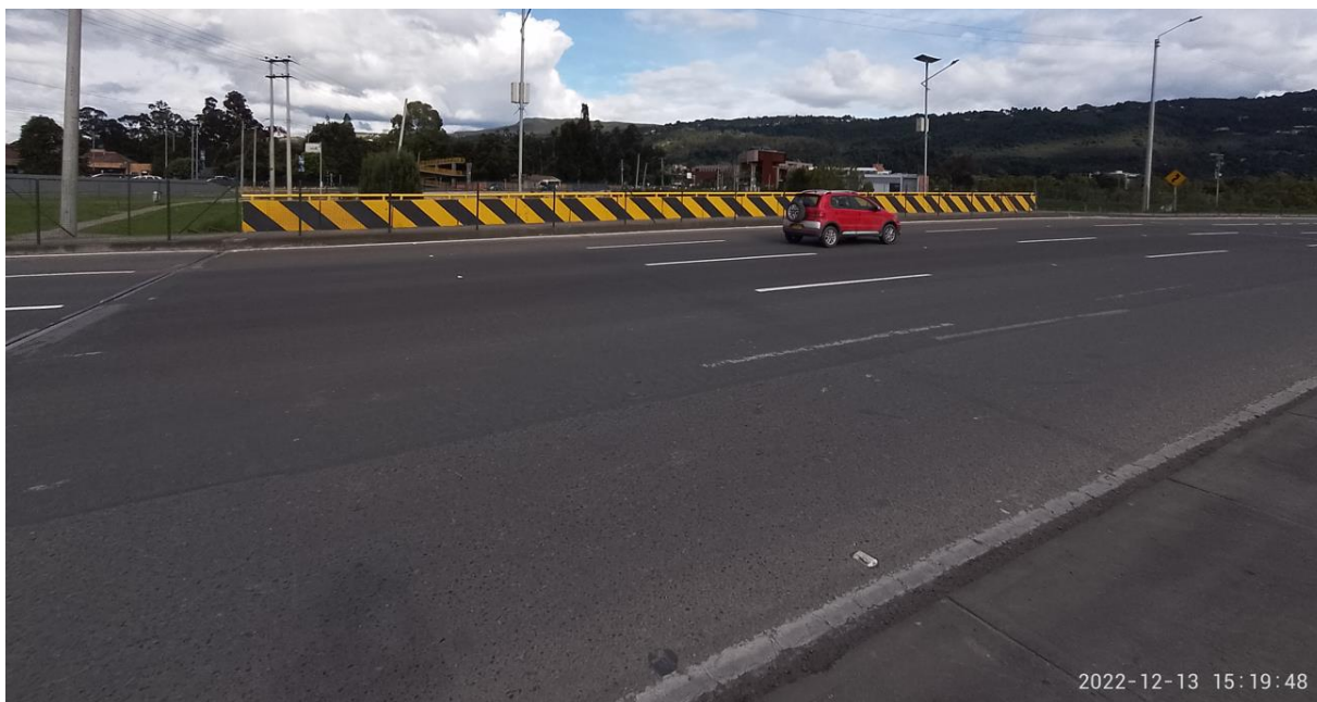
Fotografía 2. Vista General Superficie de Asfalto Fuente: Sinerging S.A.S.
