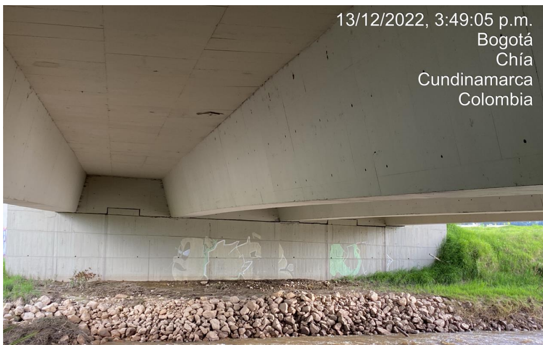
Fotografía 18. Vista Estribo 2 Rio Bogotá Nuevo Fuente: Sinerging S.A.S.
