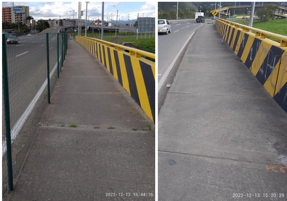
Fotografía 5. Vista Paso Peatonal Ambos Costados del Tablero Fuente: Sinerging S.A.S.
