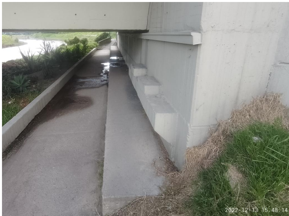
Fotografía 6. Vista Paso Peatonal Deprimido Estribo 1 Fuente: Sinerging S.A.S.
