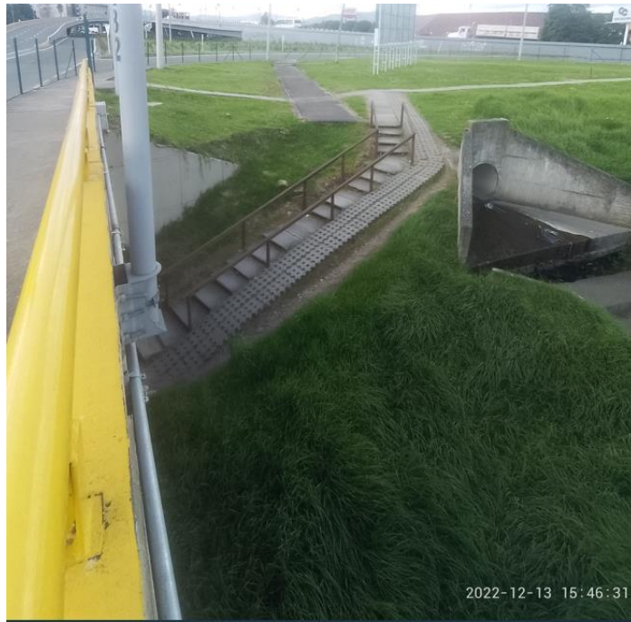
Fotografía 7. Vista Paso Peatonal Deprimido Estribo 1 Fuente: Sinerging S.A.S.
