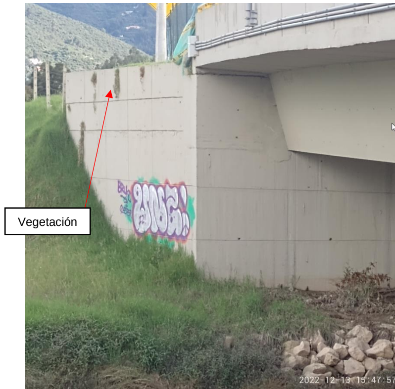
Fotografía 15. Vista Aleta Estribo 2 Costado Izquierdo Fuente: Sinerging S.A.S.
