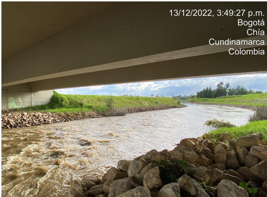
Fotografía 21. Vista de Cauce Puente Rio Bogotá Nuevo Fuente: Sinerging S.A.S.
