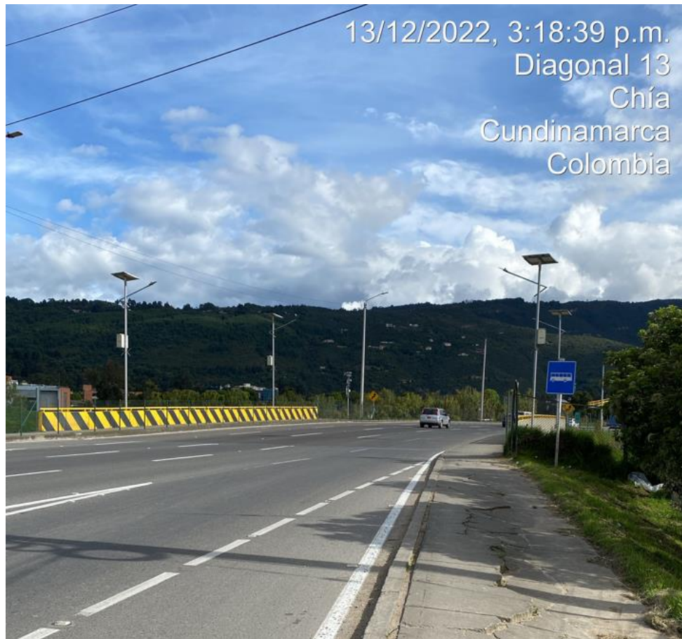
Fotografía 1. Vista General Puente Rio Bogotá Nuevo. Fuente: Sinerging S.A.S.
