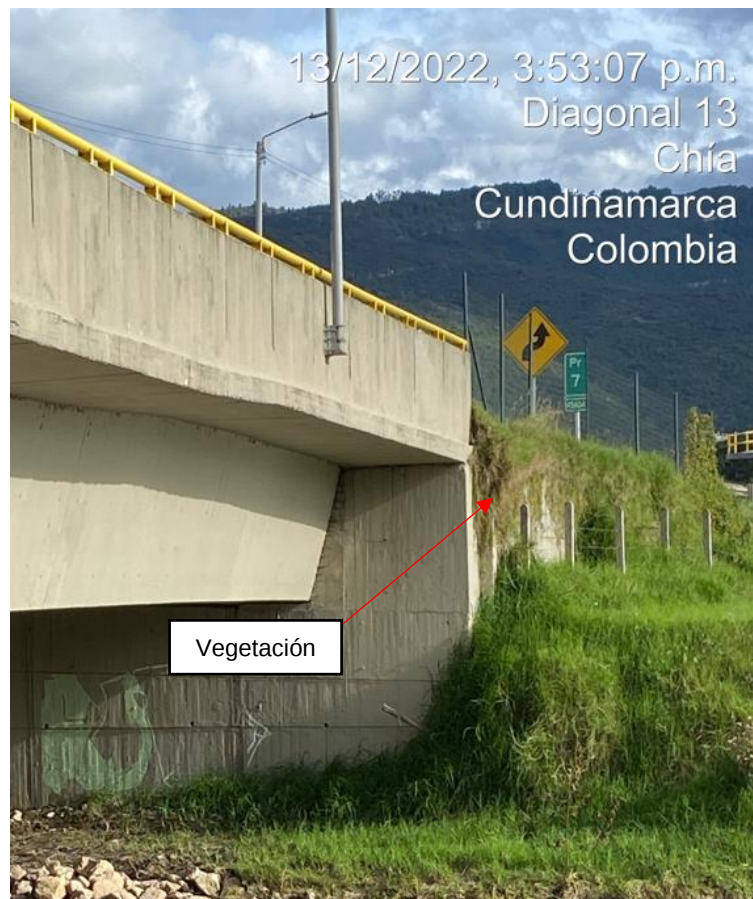
Fotografía 16. Vista Aleta Estribo 2 Costado Derecho Fuente: Sinerging S.A.S.
