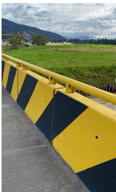
Fotografía 8. Vista Barreras Costado Izquierdo Fuente: Sinerging S.A.S.
