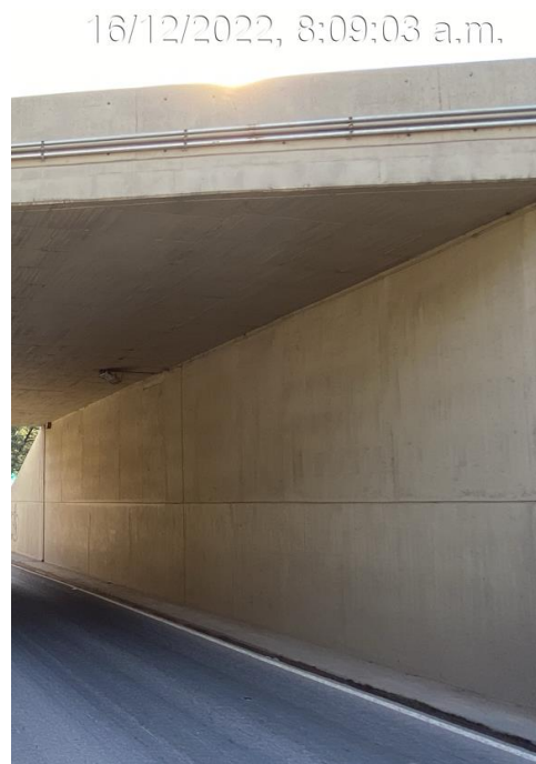
Fotografía 14. Vista Estribo Sur Hato Grande Oriental Fuente: Sinerging S.A.S.
