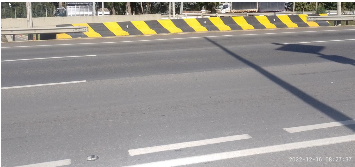
Fotografía 5. Barreras De Concreto Fuente: Sinerging S.A.S.
