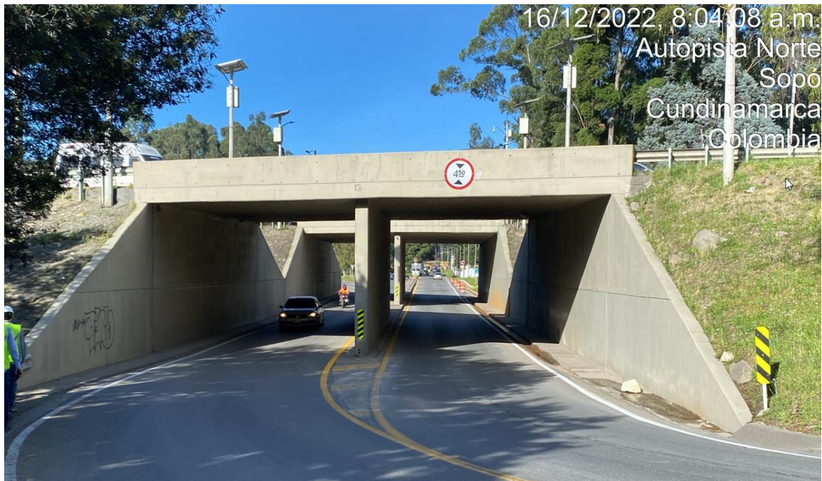
Fotografía 1. Vista General Deprimido Hato Grande Oriental Fuente: Sinerging S.A.S.
