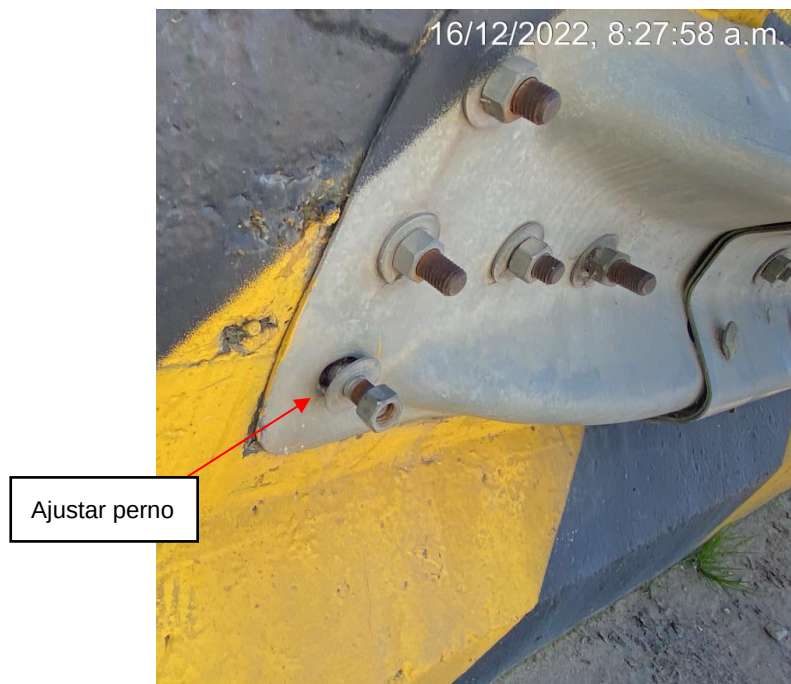
Fotografía 8. Barreras De Concreto Fuente: Sinerging S.A.S.
