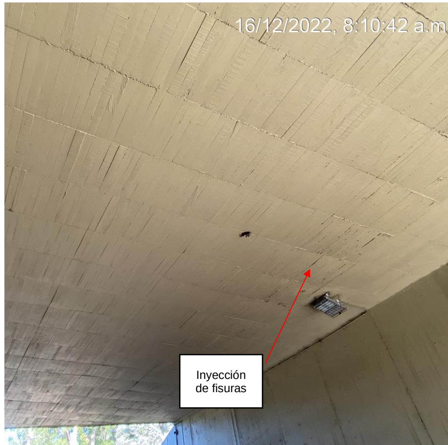
Fotografía 17. Vista De Losa Fundida In Situ Fuente: Sinerging S.A.S.
