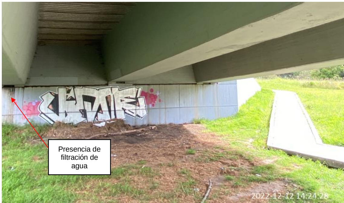
Fotografía 16. Vista estribo eje A Fuente: Sinerging S.A.S.
