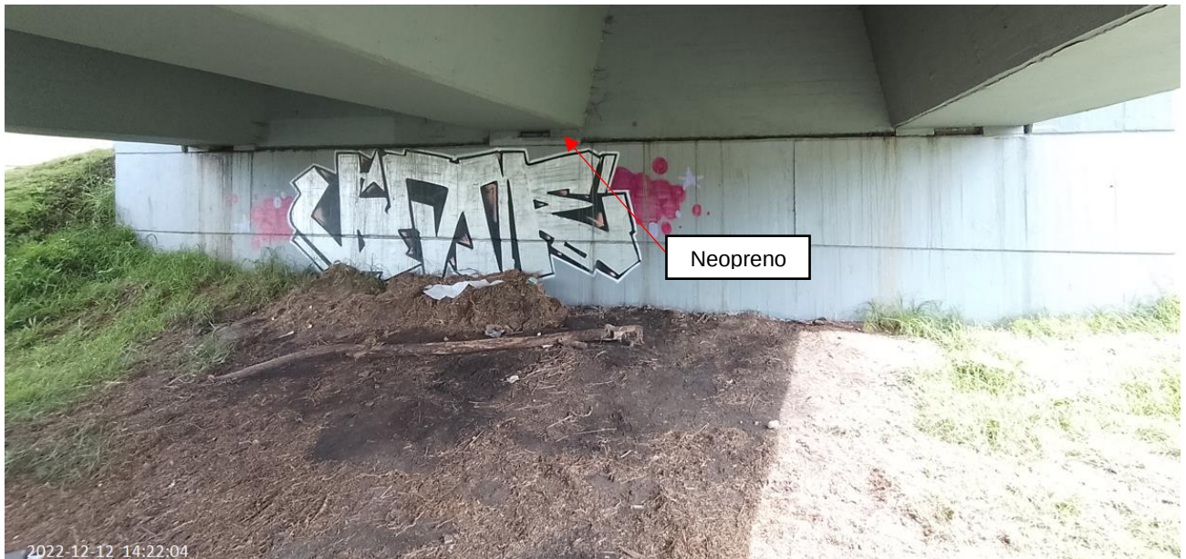
Fotografía 11. Vista de apoyos en estribo eje A Fuente: Sinerging S.A.S.
