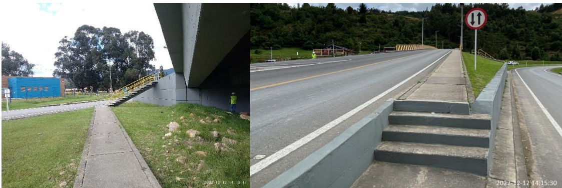
Fotografía 24. Acceso puente los clubes estribo F. Fuente: Sinerging S.A.S.
