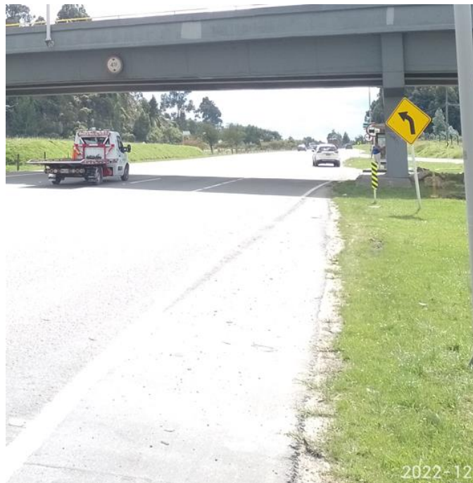
Fotografía 9. Señalización del puente sentido vía Bogotá. Fuente: Sinerging S.A.S.
