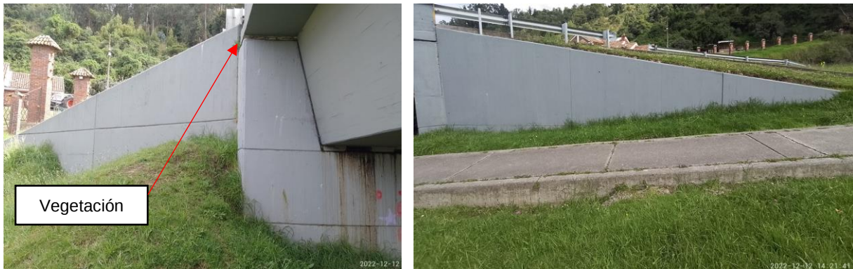
Fotografía 14. Vista aleta estribo eje A Fuente: Sinerging S.A.S.
