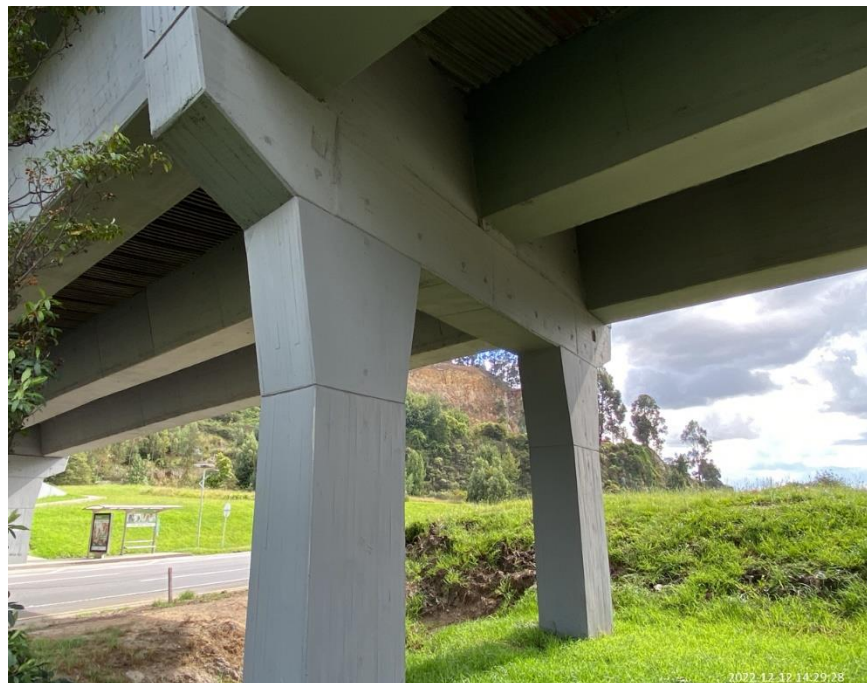
Fotografía 13. Vista general de apoyos en pilas Fuente: Sinerging S.A.S.
