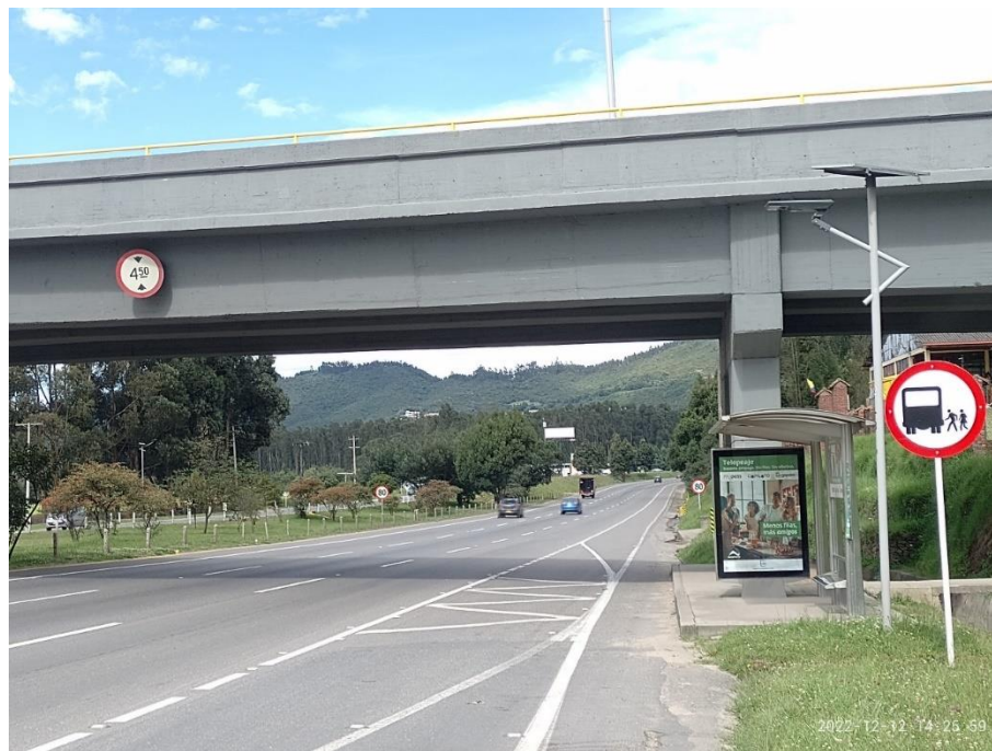
Fotografía 10. Señalización del puente sentido vía Tunja. Fuente: Sinerging S.A.S.
