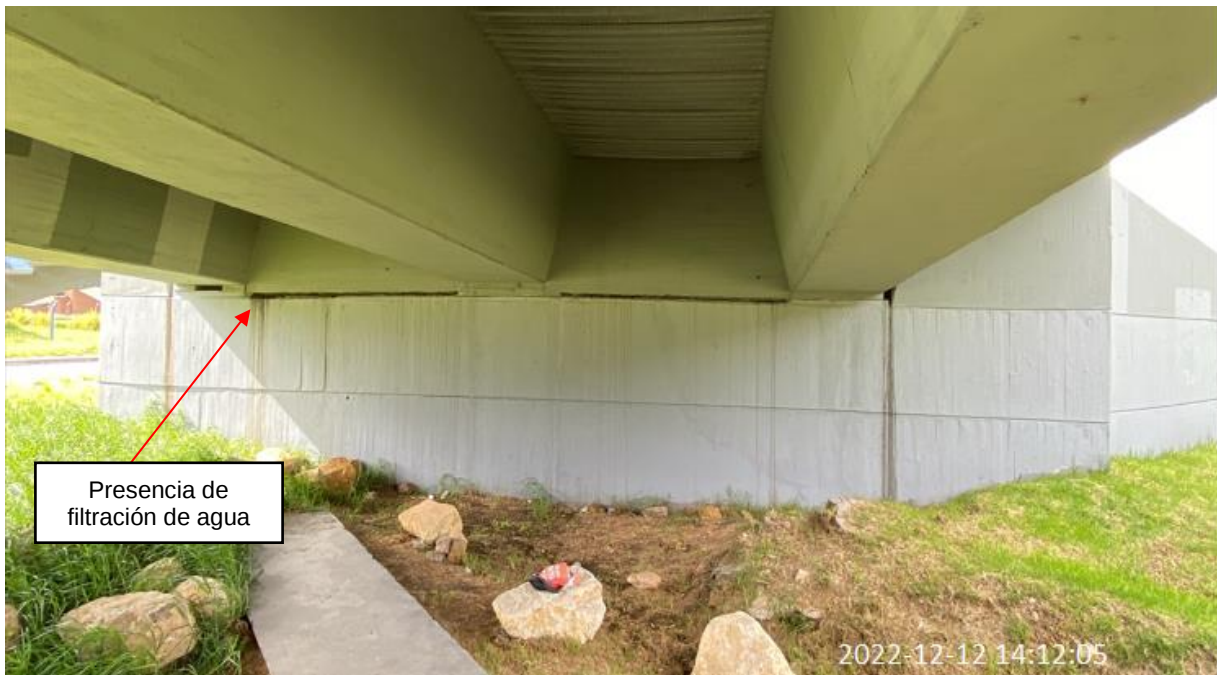
Fotografía 17. Vista estribo eje F Fuente: Sinerging S.A.S.
