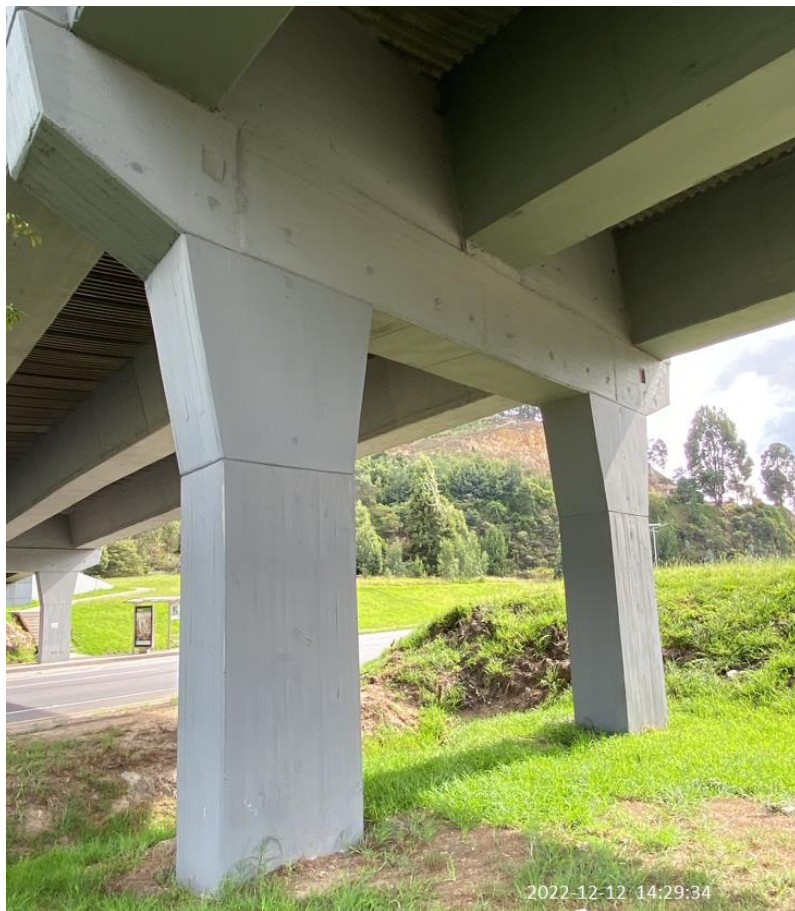
Fotografía 18. Vista pila típica Fuente: Sinerging S.A.S.
