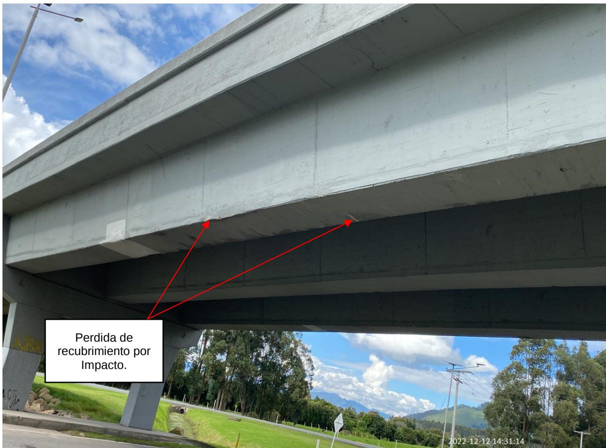
Fotografía 22. Vista de vigas entre ejes C y D. Fuente: Sinerging S.A.S.
