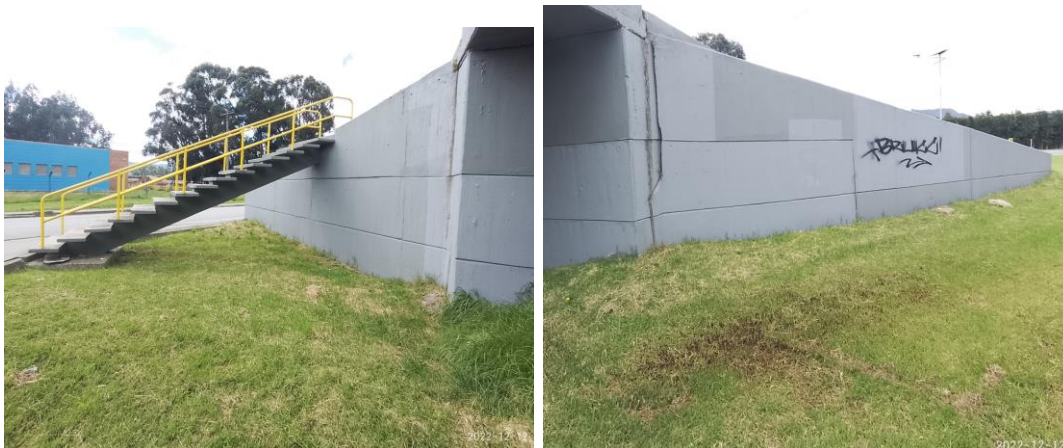
Fotografía 15. Vista aleta estribo eje F Fuente: Sinerging S.A.S.
