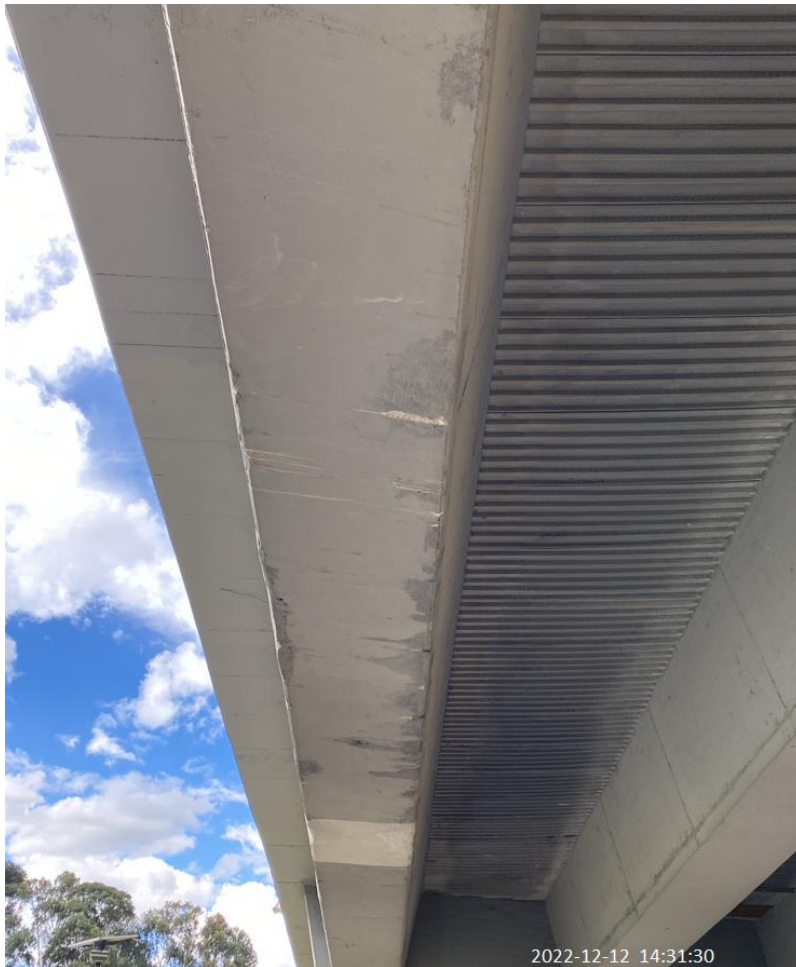
Fotografía 20. Vista de prelosa + losa fundida in situ Fuente: Sinerging S.A.S.
