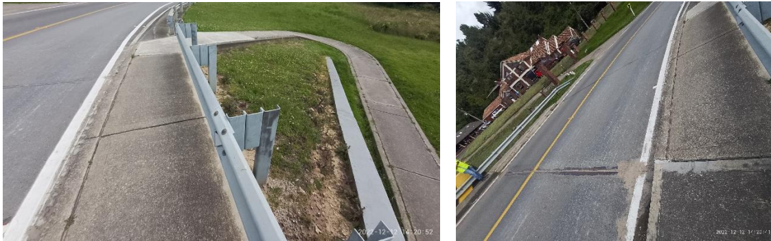
Fotografía 23. Acceso puente los clubes estribo A. Fuente: Sinerging S.A.S.
