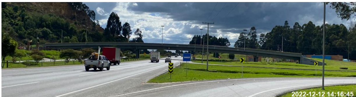
Fotografía 1. Vista General Intercambiador los clubes Fuente: Sinerging S.A.S.
