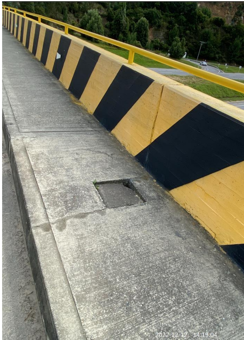
Fotografía 7. Baranda en concreto con pasamano metálico Fuente: Sinerging S.A.S.
