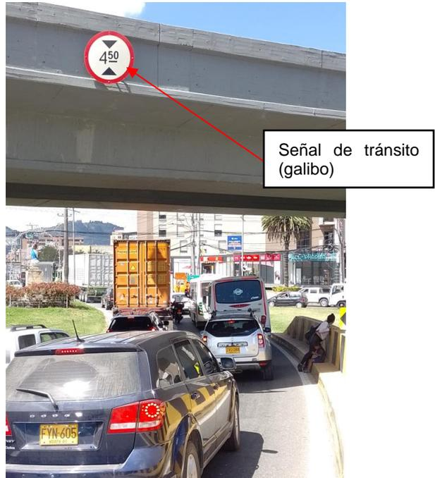
Fotografía 13. Señalización salida puente chia ramal
