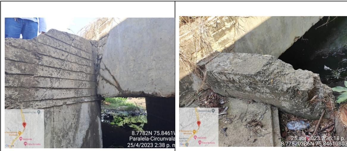
**DESCRIPCIÓN:** La aleta izquierda de encofe presenta fisuras en la unión entre el estribo y la aleta.
