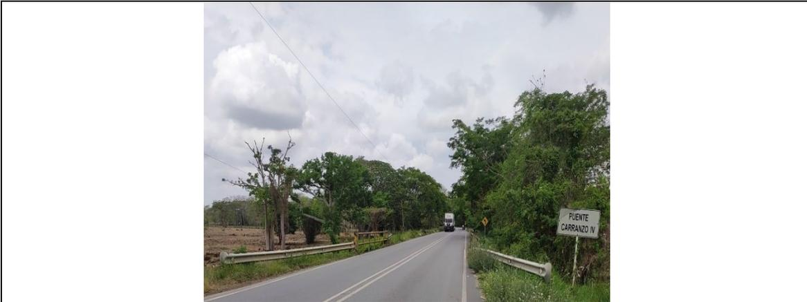
**DESCRIPCIÓN:** La superficie de rodadura es en Asfalto, en buen estado. Juntas de Expansión ocultas, no presenta andenes y bordillos.
