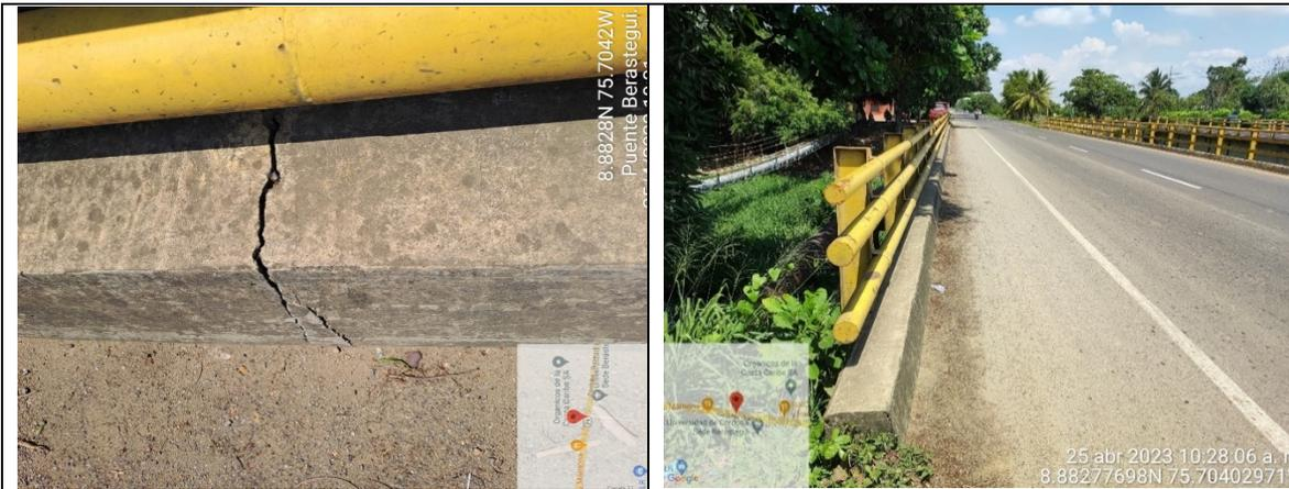
**DESCRIPCIÓN:** Superficie de rodadura en buen estado. Bordillo con fisuras transversales. Delaminación de pintura en las barandas.
