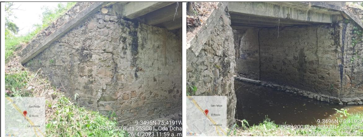
**DESCRIPCIÓN:** Fisura en aletas. Fisura horizontal en estribo. Contaminación del concreto.
