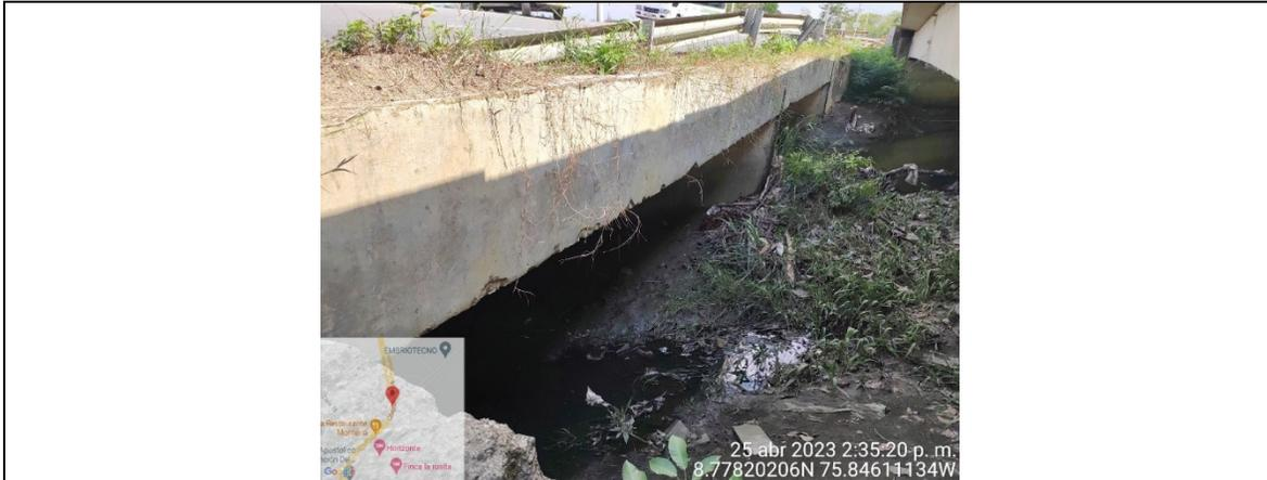
**DESCRIPCIÓN:** Descascaramiento en el borde de la losa de encofe.
