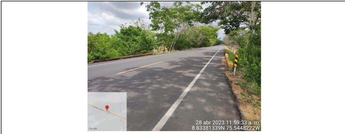
**DESCRIPCIÓN:** La superficie de rodadura es en Asfalto, en buen estado. Juntas de Expansión ocultas, no presenta andenes y barandas.
