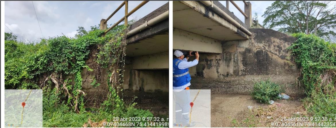
**DESCRIPCIÓN:** Aleta Encole costado izquierdo / Aleta Encole costado derecho, colmado de maleza y contaminación del concreto.
