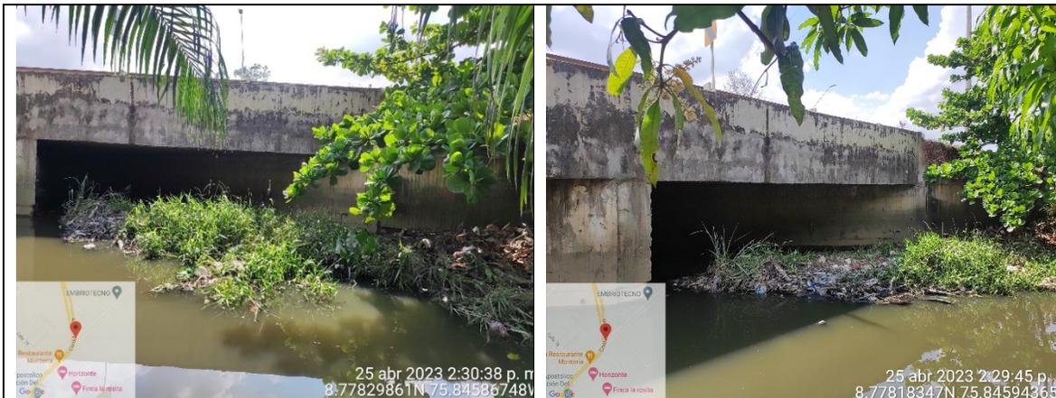
El puente se encuentra en buen estado general, sin embargo, requiere mantenimiento rutinario para retiro de sedimento, vegetación y basuras estancadas.
