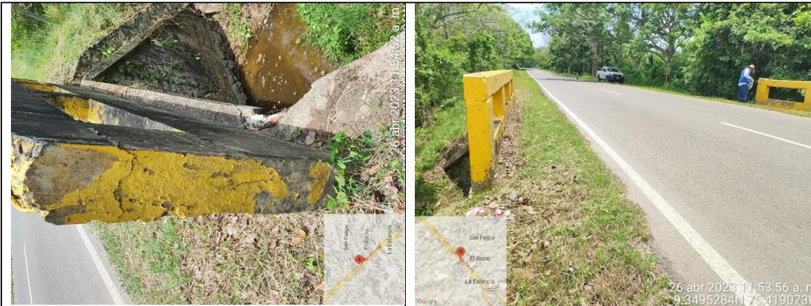
**DESCRIPCIÓN:** Superficie de rodadura en buen estado. Delaminación de pintura de barandas.
