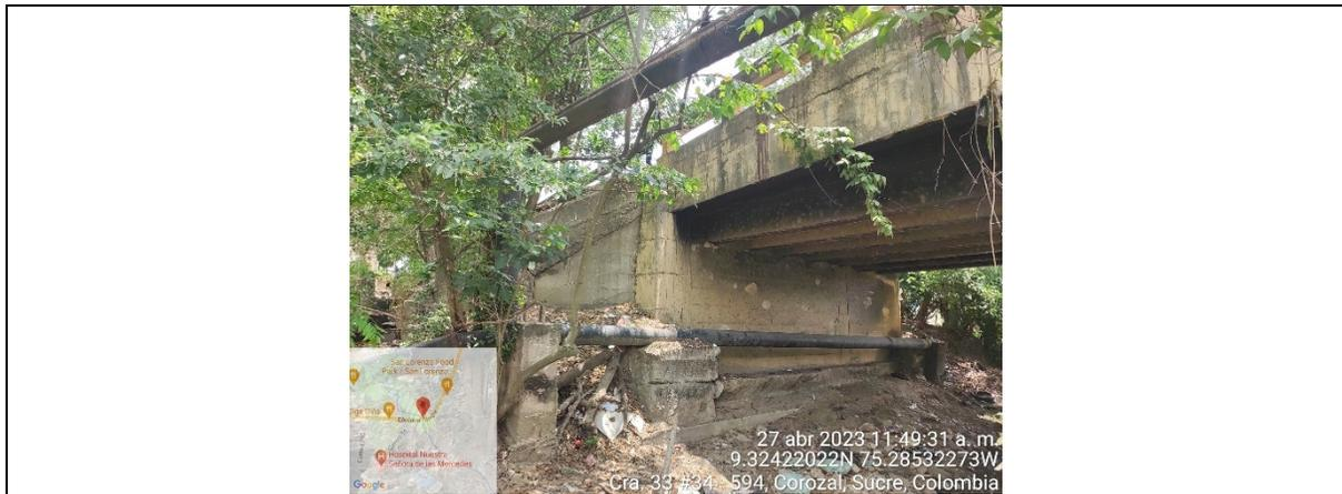
**DESCRIPCIÓN:** Se encuentra en regular estado, presenta aleta y estribos fisurados, fluorescencia en la losa y concreto contaminado.
