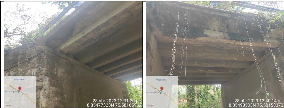
**DESCRIPCIÓN:** La losa con 7 vigas, en los bordes presenta contaminación del concreto.
