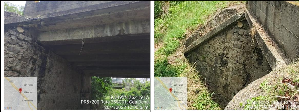
**DESCRIPCIÓN:** Cuenta con 7 vigas, apoyos y losa en buen estado.
