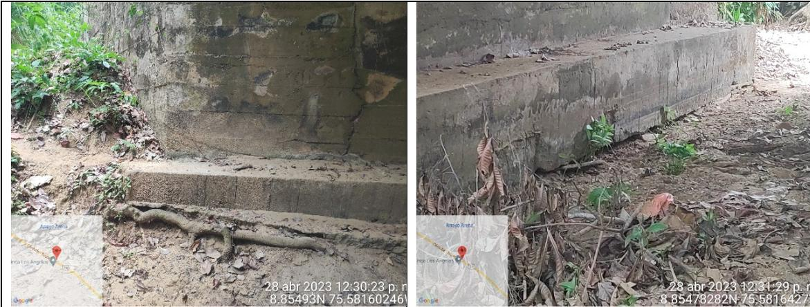
**DESCRIPCIÓN:** Estribos. En cimentación presentan socavación y contaminación del concreto.
