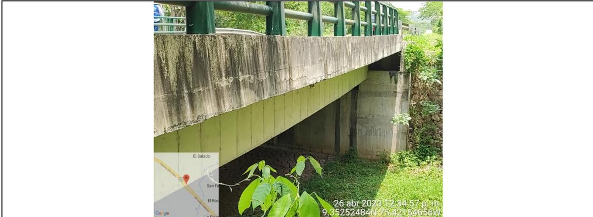
**DESCRIPCIÓN:** Losa, 4 vigas y apoyos en buen estado.
