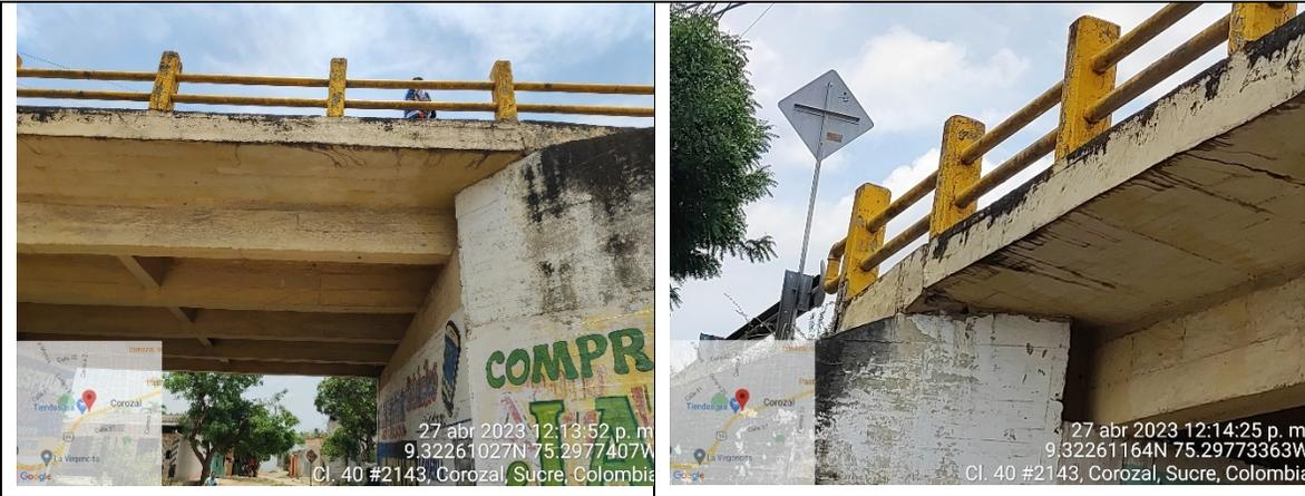
**DESCRIPCIÓN:** 5 vigas en buen estado. Losa en buen estado.
