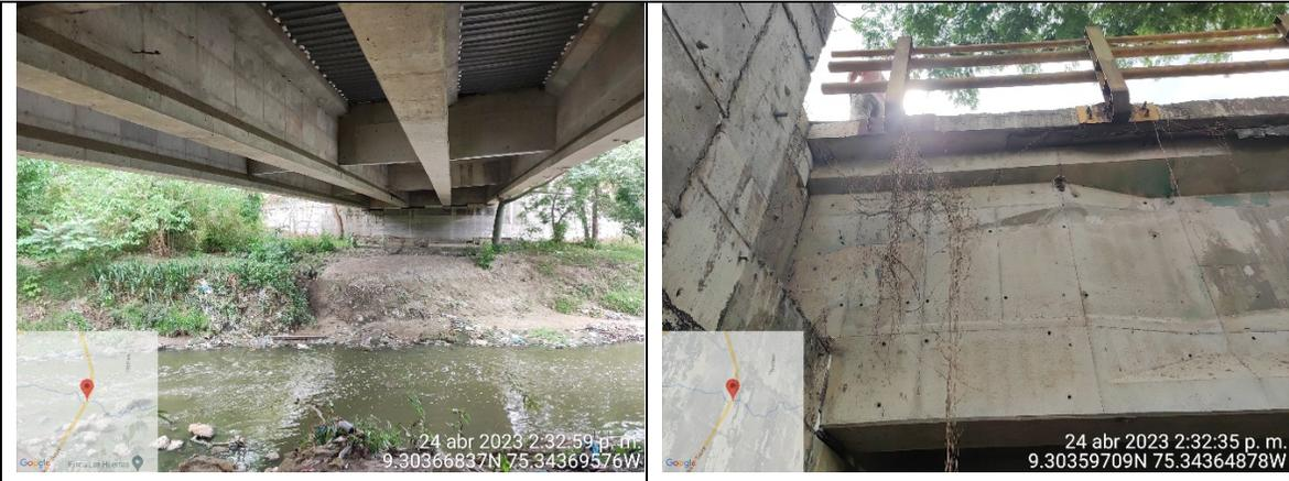
**DESCRIPCIÓN:** Cuenta con 5 vigas y losa en buen estado.
