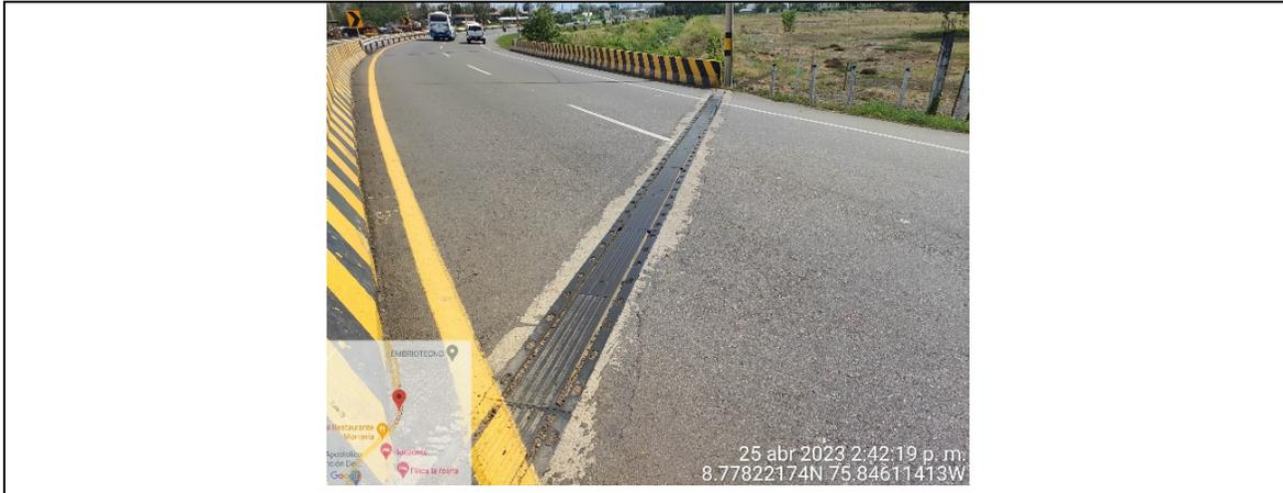
**DESCRIPCIÓN:** La superficie de rodadura y los accesos peatonales (escaleras) se encuentra en buen estado, al igual que las juntas de expansión. Cuenta con barreras de concreto tipo Jersey pintadas y en buen estado. La señalización vertical consta de delineadores de curva. La iluminación nocturna funciona correctamente.
