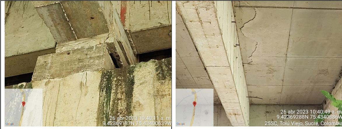
**DESCRIPCIÓN:** Cuenta con 4 vigas. La viga del centro con fisuramiento en apoyo y excéntrica en el otro extremo
