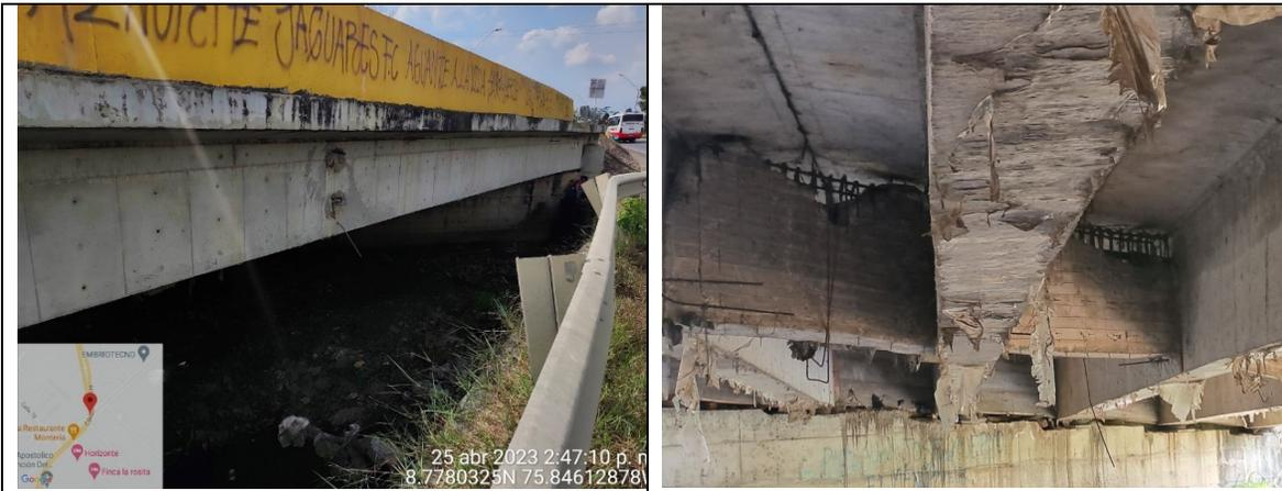
**DESCRIPCIÓN:** Losa con 6 vigas, presenta mal proceso constructivo en la fundida de los diafragmas, acero expuesto.
