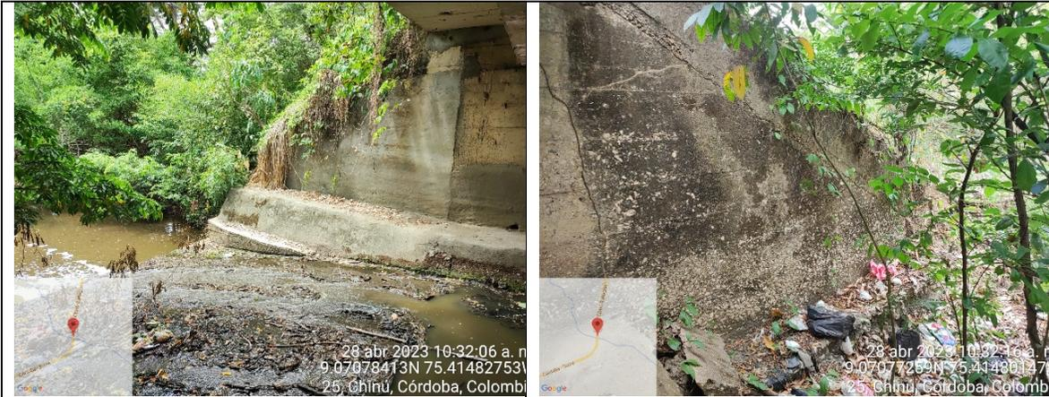
**DESCRIPCIÓN:** Aleta Descole costado derecho tapada por vegetación / Aleta Encole costado derecha, presenta fisura y contaminación del concreto.
