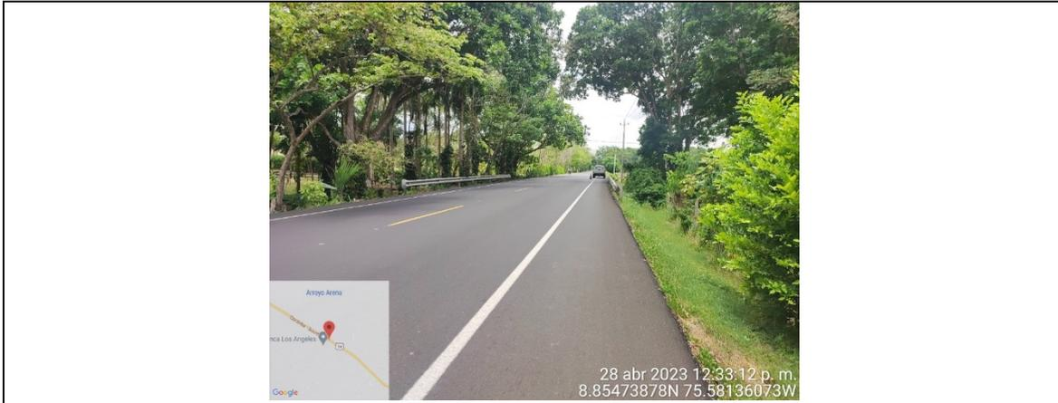
**DESCRIPCIÓN:** La superficie de rodadura es en Asfalto, en buen estado. Juntas de Expansión ocultas, no presenta andenes, bordillos y barandas. Protegida con Defensa metálica.
