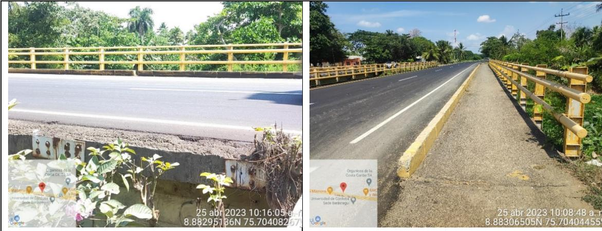
**DESCRIPCIÓN:** Superficie de rodadura en buen estado. Ausencia de dos postes y un tramo de pasamanos en el costado izquierdo.
