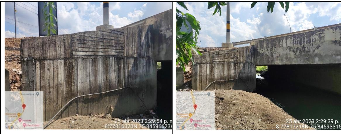
**DESCRIPCIÓN:** Las aletas de descofe y los estribos se encuentran en buen estado al igual que el muro intermedio.
