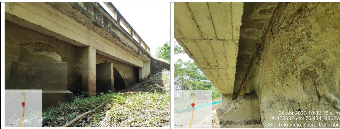
**DESCRIPCIÓN:** Arcos en concreto. Refuerzo con vigas laterales para ampliación de calzada. Presenta fisura en arco central y contaminación del concreto.
