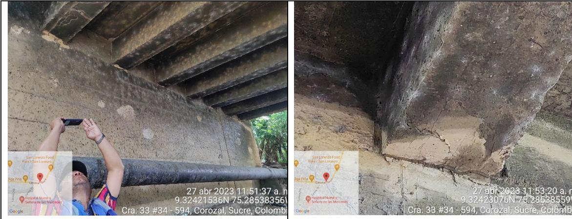
**DESCRIPCIÓN:** Losa con fluorescencia. Consta de 7 vigas. Viga de borde izquierdo presenta fisuras al borde con el apoyo.
