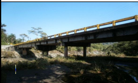
FOTO 3: VISTA PANORAMICA LONGITUDINAL
