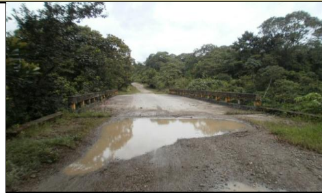
FOTO 2: PLACA IDENTIFICACIÓN PUENTE - NO EXISTE
