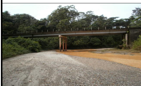
FOTO 3: VISTA PANORAMICA LONGITUDINAL
