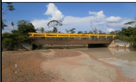
FOTO 3: VISTA PANORAMICA LONGITUDINAL
