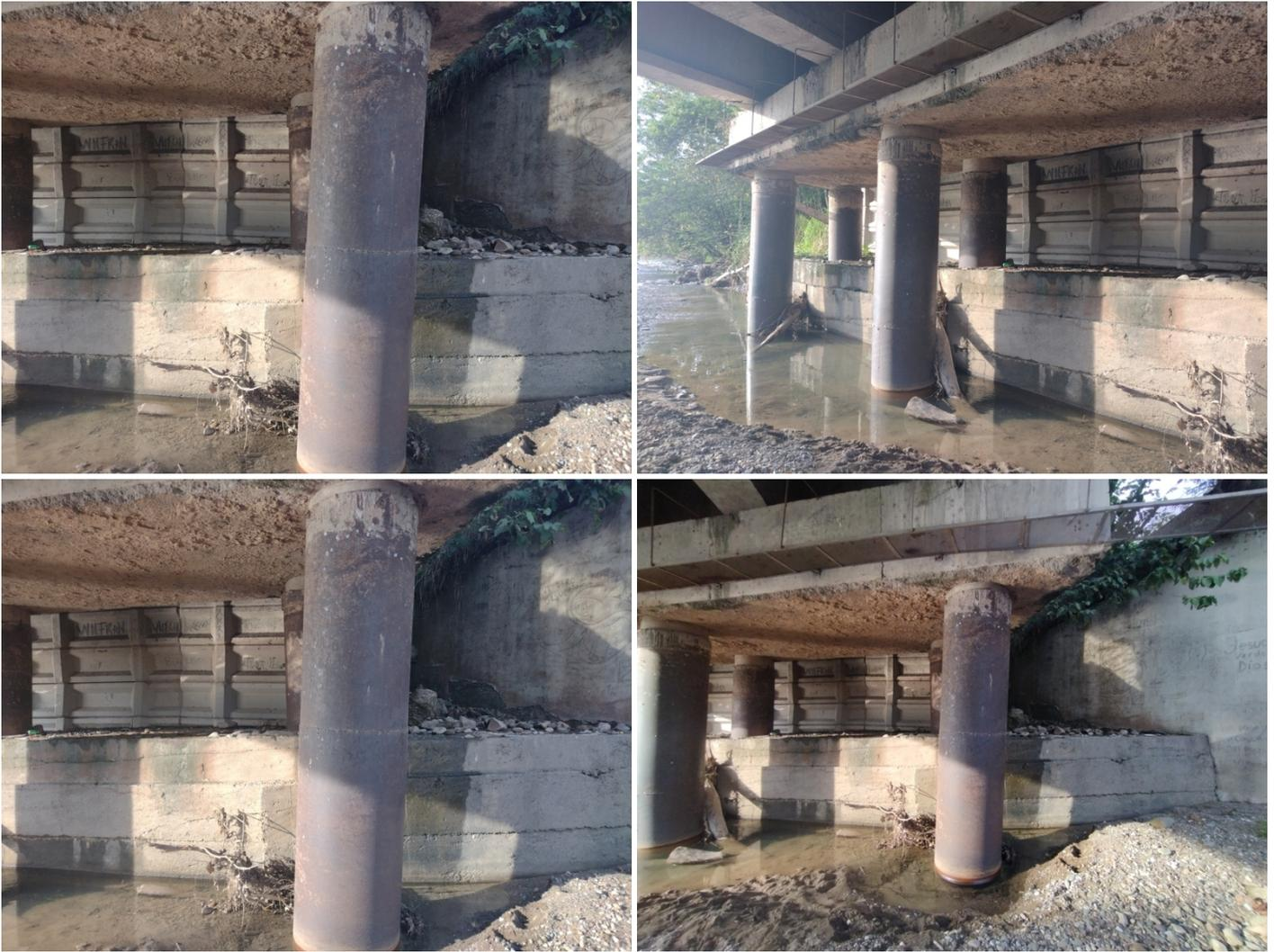
**Observaciones:** Estribos conformados por cabezotes y 6 pilotes con camisa metálica. Adicionalmente presenta protección de orilla. Se observa el pilote exterior aguas arriba inclinado.
