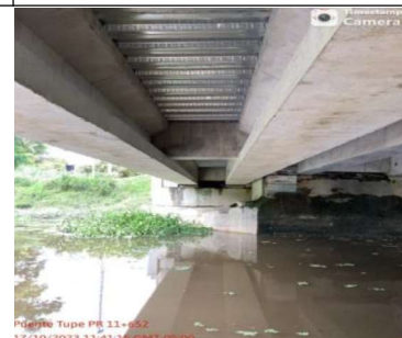
Puente Tupé PR 11+652 17/10/2023 11:41:18 GMT-05:00
