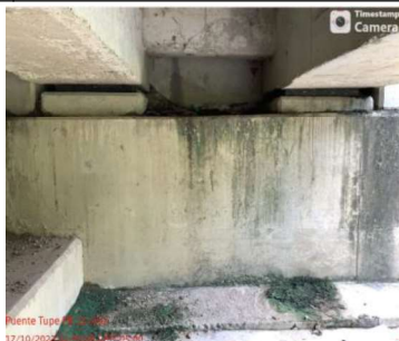
Puente Tupé PR 11+652 17/10/2023 11:46:25 GMT-05:00
