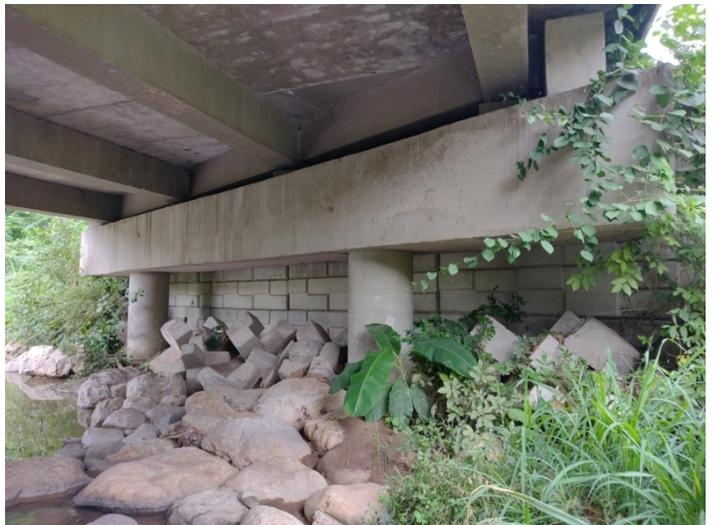
**Observaciones:** Estribo conformado por viga cabezal y 2 pilotes, no tiene aletas y si tiene tope sísmico. pilotes con un diámetro de 0.80 m y separados a 7.00 m a ejes, la viga cabezal es de 1.25 m x 1,10 m. La altura libre de 2.0 m.
