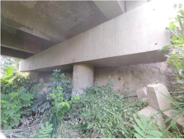
**Observaciones:** | Viga cabezal con dos pilas. La altura de la viga cabezal es de 1.10 m.
