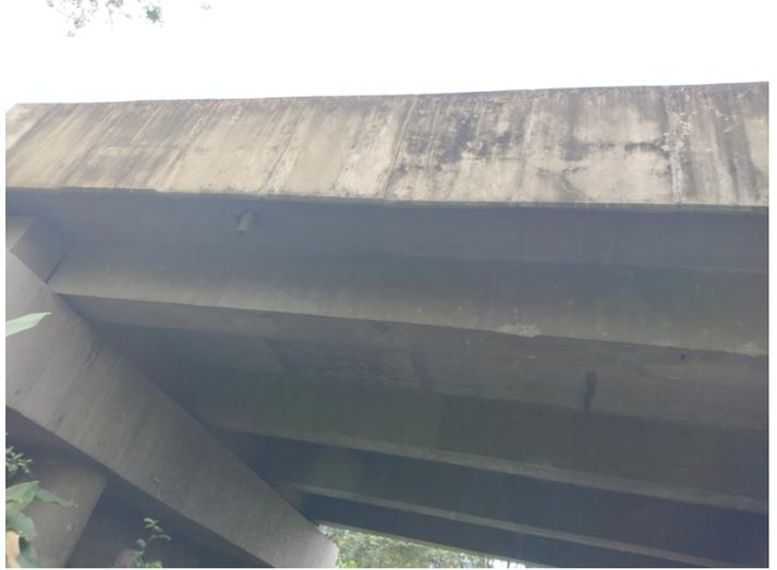
**Observaciones:** | Drenajes del costado derecho. Hay un ducto tapado.
