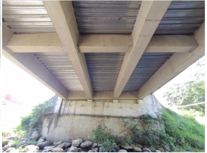
**Observaciones:** Se debe realizar seguimiento a las fisuras por cortante en las vigas, adicionalmente se debe revisar la capacidad de la superestructura.
