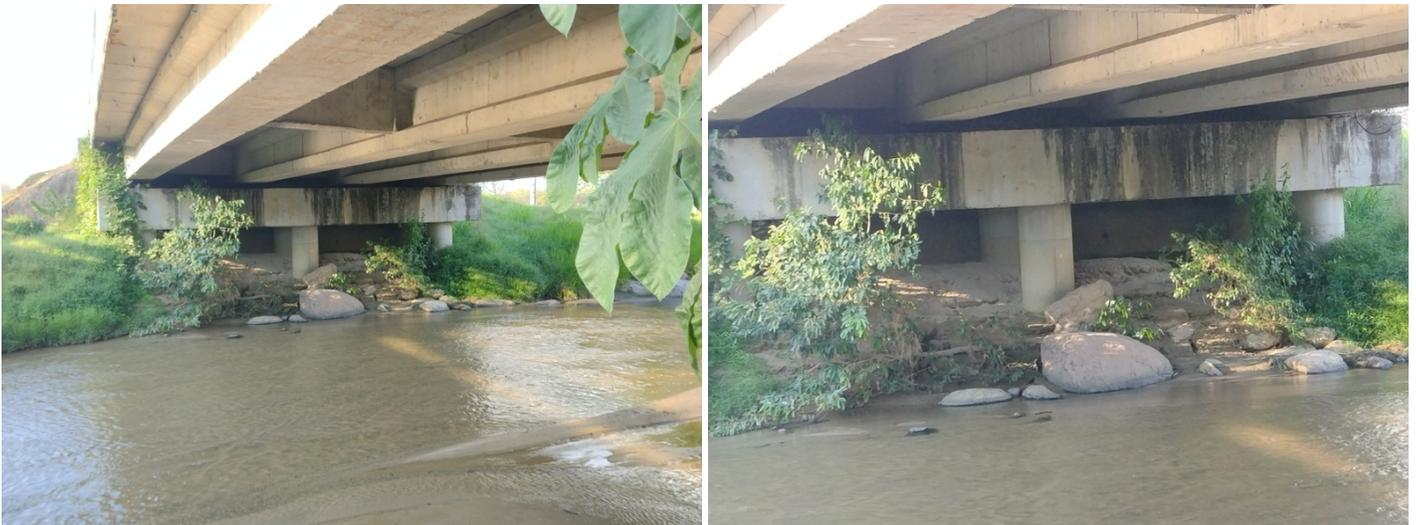
**Observaciones:** 6 pilas y una viga cabezal de 1.10 m de altura. No fue posible determinar más dimensiones en este elemento.
